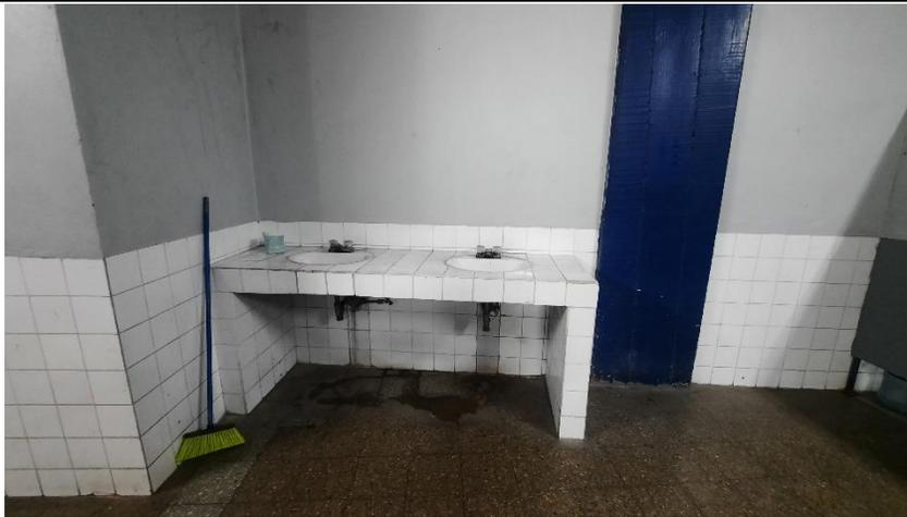
No. 4 Se observa mueble de concreto enchapado con cerámica en uno de los módulos de baños de hombres, la mayoría de los aparatos hidrosanitarios se encuentra en mal estado
