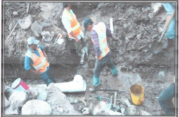
**DESCRIPCION:** Se comenzo con la reparacion en el daño presentado , con Personal de Aguas de la Sierra de Montecillos , se hizo el cambio de la tuberia y de la TEE de 8" juntos con los reductores.
