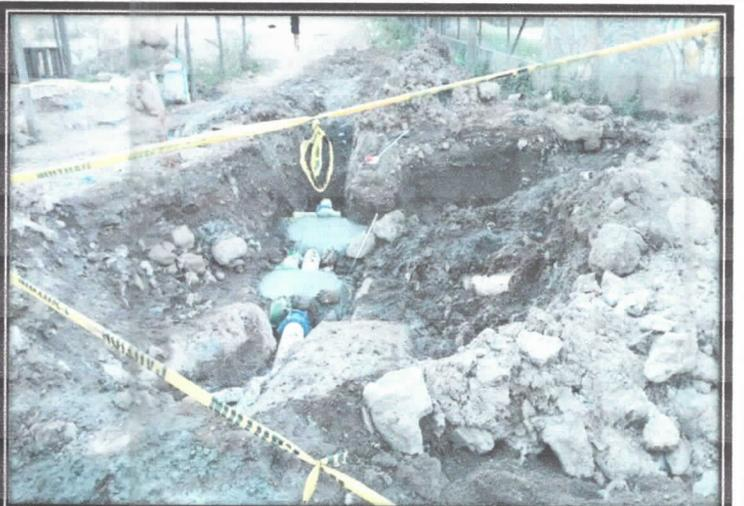
**RESULTADO;** Al final se hizo la reparacion y se procedio ala fundicion de los anclajes en los accesorios para evitar cualquier falla al momento de la puesta en marcha nuevamente del sistema.
