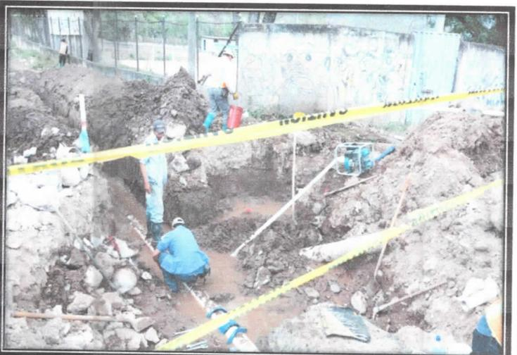
**RESULTADO;** La primera actividad fue demoler un anclaje de gran tamaño que fue construido de forma innecesaria en el lugar de la obra, al llegar a la tubería se pudo ver que no se trabajo con los requerimientos Tecnicos adecuados y la falla estaba en una tee de 8" que se encontraba fisurada.
