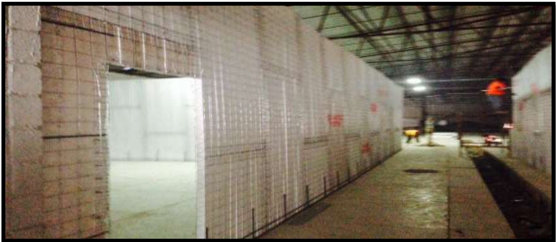
AVANCES DE LA CONSTRUCCION DE PAREDES DE LAS AULAS
