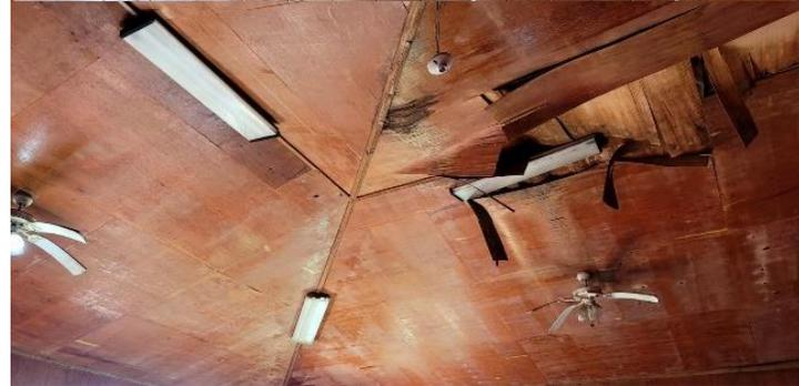
**4. REPARACIÓN DE ESTRUCTURAS DE CIELO Y SUSTITUCIÓN DE CUBIERTA DE ALUZINC**
