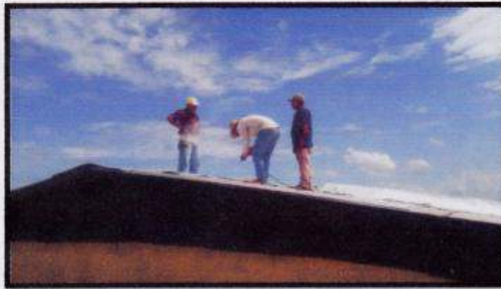
4.5 Reparación de techo en Escuela Republica de México. Se cambiaron algunas láminas en mal estado y se cambio el caballete.
