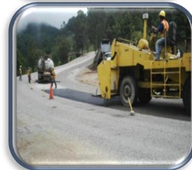
Se cuenta con un tramo de 10 km de longitud aproximadamente, listo para ser mezclado con cemento y posteriormente ser pavimentado, según el diseño unos tramos con doble tratamiento superficial asfáltico y los demás tramos con concreto hidráulico de 3,000 PSI.
