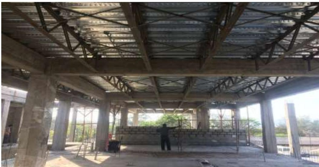
**Losa de Techo con lamina Galvadeck calibre 24**
