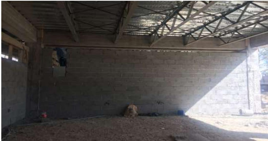
**Colocación de bloque de 4" con bastoneado, fundido con concreto 2500PSI**
