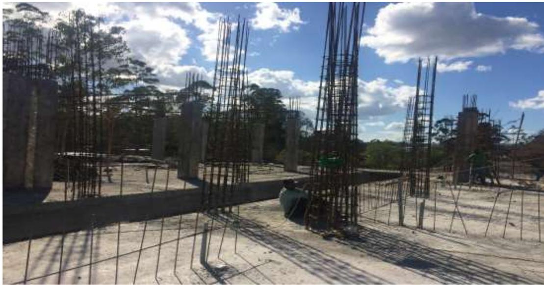
**Armado Y colocación de Castillos**
