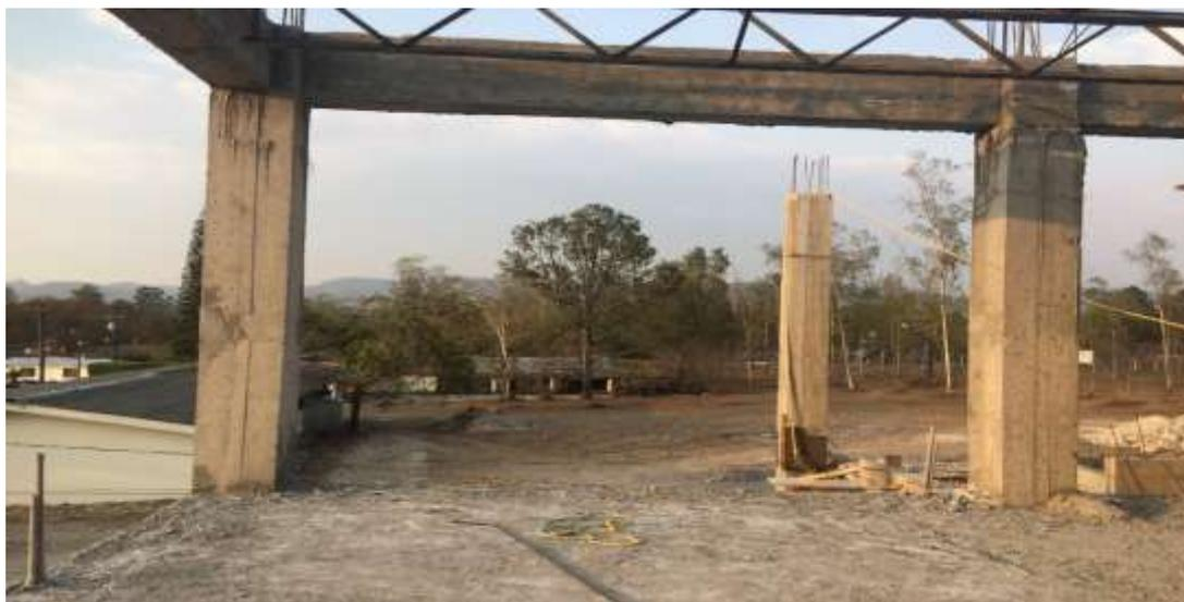
**Fundición de Columnas perimetrales del segundo nivel de 45x45cms con varilla 16#4,**
