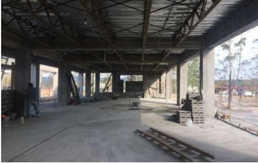
**Fundición de Losa de concreto de 8cm espesor con malla electrosoldada incluye lamina Galvadeck calibre 24**
