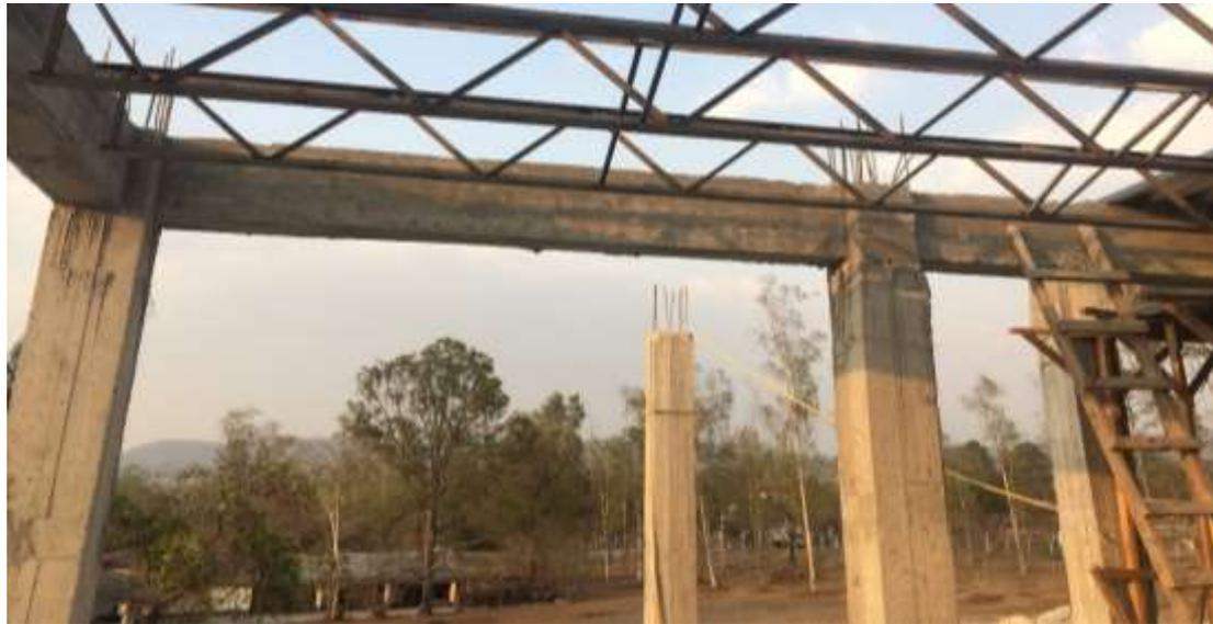
**Se terminó de fundir las vigas V-2 en losa de Techo**
