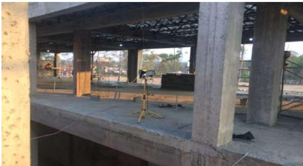
**Se terminó la fundición de Columnas de 45x45cms con varilla 16#4, en el Segundo Nivel**
