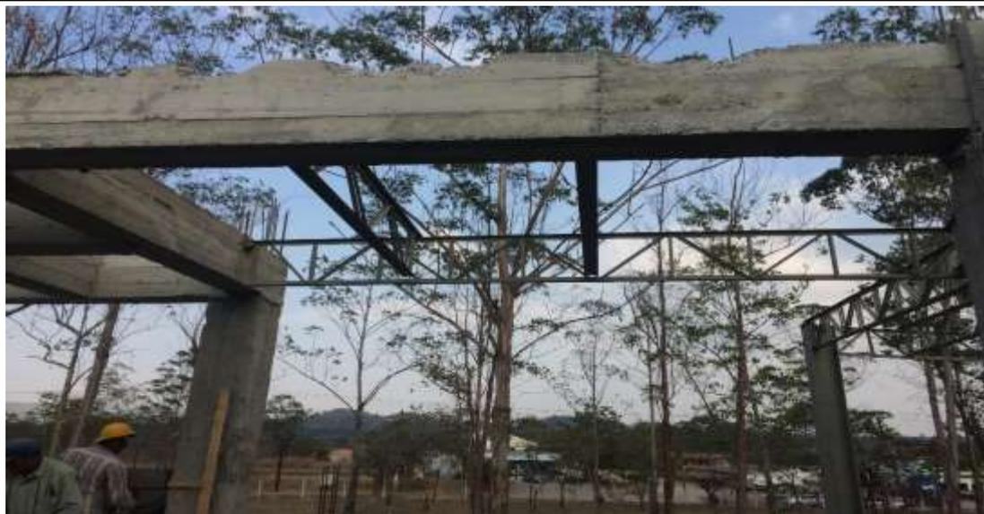
**Se terminó de fundir las Vigas V-1 en losa de Techo**
