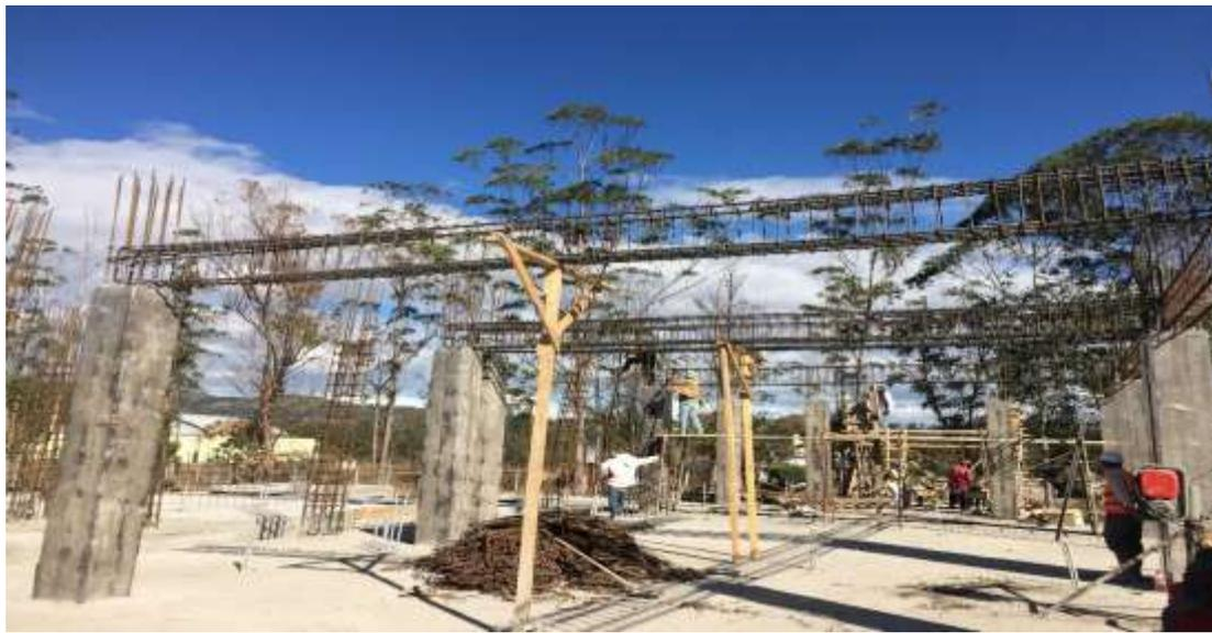
**Armado de Vigas V-1 en Azotea**
