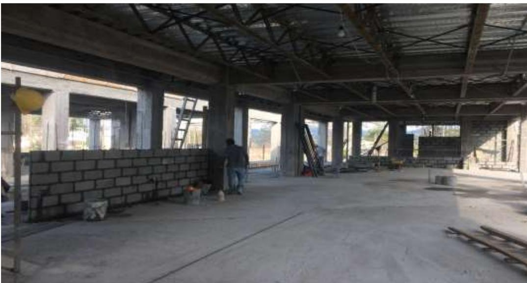
**Colocación de bloque de 4" con bastoneado, fundido con concreto 2500PSI**
