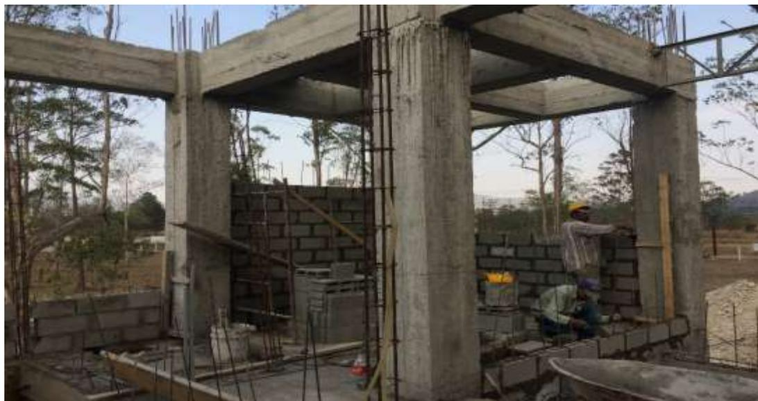
**Armado Y colocación de Castillos**
