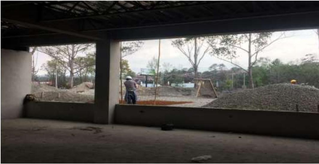
**Colocación de bloque de 6" con bastoneado, fundido con concreto 2500PSI**
