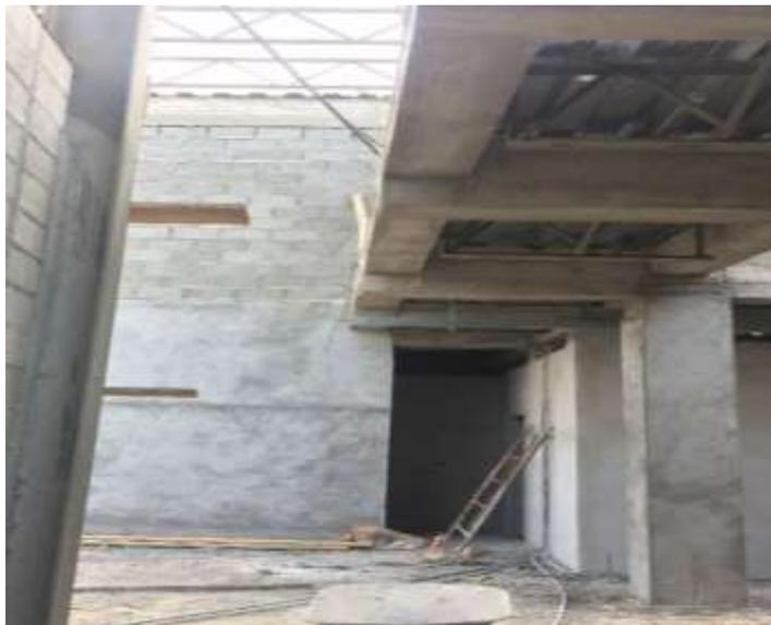
**Se terminó de fundir las Vigas V-3 en losa de Segundo Nivel**
