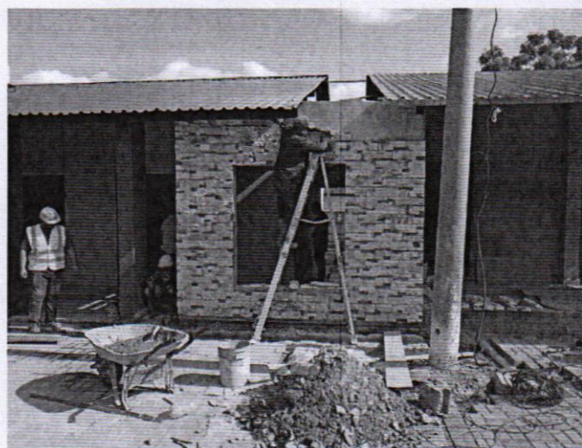
Enchape en pared, cocina edificio #2 – Aduana Guasaule
