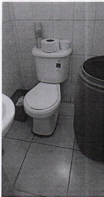
Instalación de sanitarios de hombres y mujeres.
