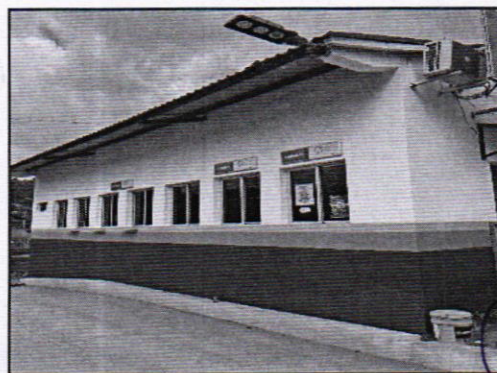
Pintura en módulos TIM.
