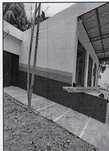
Portón de acceso a bodega.
