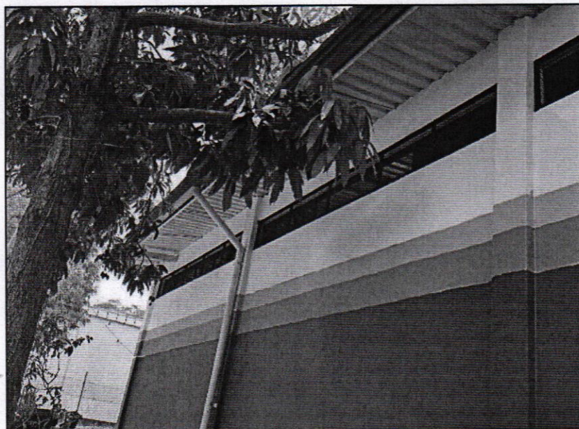
Fachada trasera con canal de aguas lluvias
