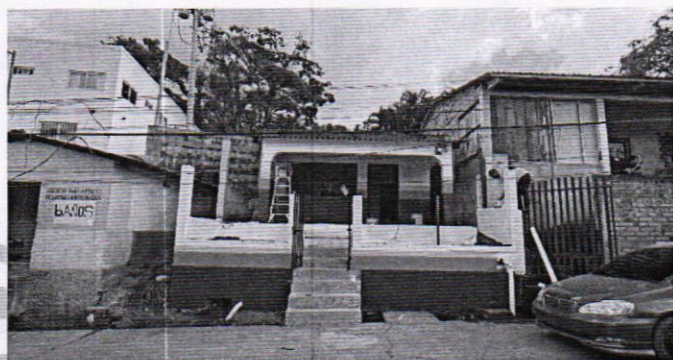
Rehabilitación de vivienda.
