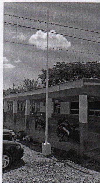
Instalación de asta de Bandera.
