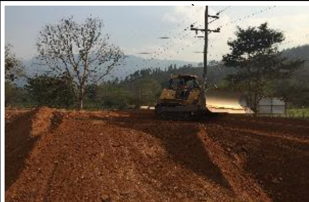
Incorporación de Tractor para mejorar avance constructivo de las lagunas
