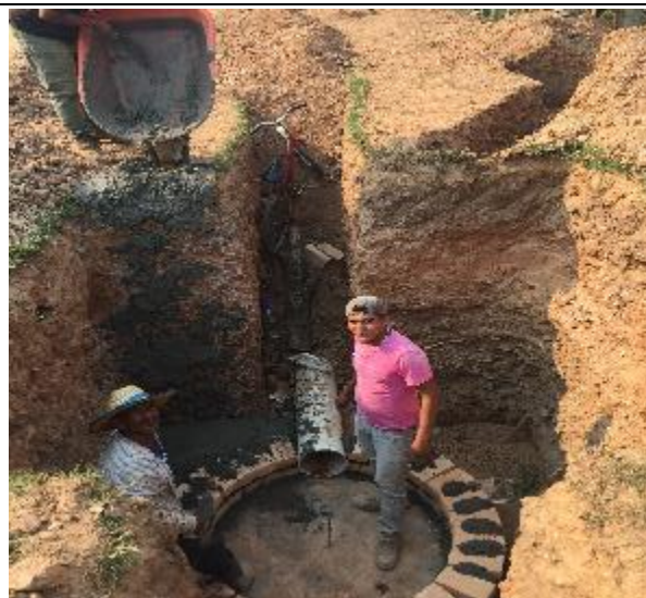
Pozo P-164 A en construcción. Hacia las lagunas
