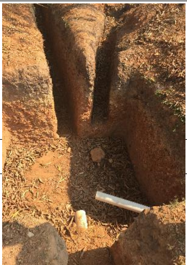
Pozo P-79 solo excavado
