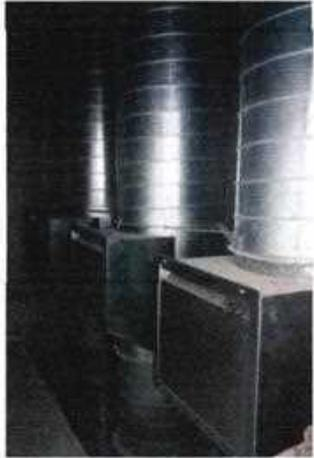
Fig. 1. Ductos de las basuras en el Edificio 1847
