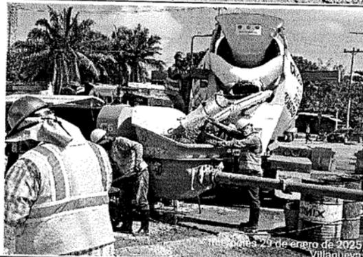
Vista de Mixer de CONHSA descargando el concreto en tolva para la fundición de zapata en el proyecto Intercambiador de Villanueva.
