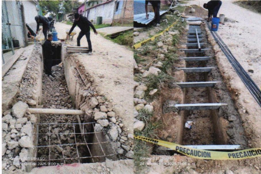
*Demolición y trabajos preliminares para la reconstrucción de tramos de embaulados dañados.*
