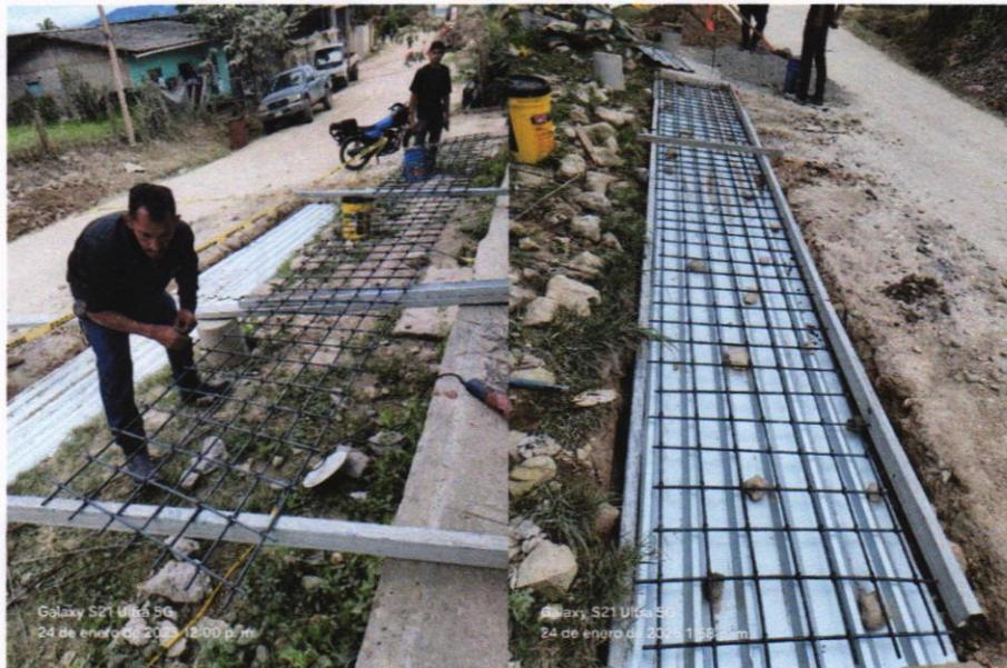
*Armado de refuerzo para losa aligerada en tramo de embaulados dañados.*
