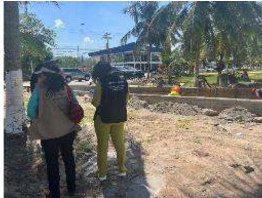
Inspección construcción de puente porvenir de Barrio El Porvenir, Sector El Porvenir.
