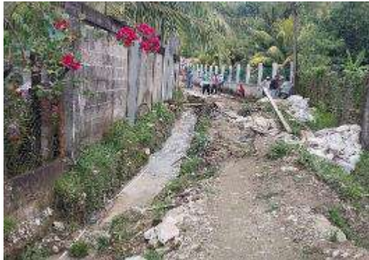
Inspección de construcción de avance de proyecto de canal pluvial de Puente Alto, Sector Puente Alto.
