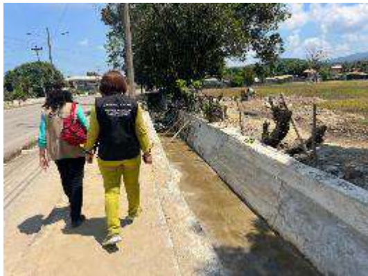
Inspección de construcción de canales y adoquinado de la CA5 de Barrio Cienaguita, Sector El Porvenir.
