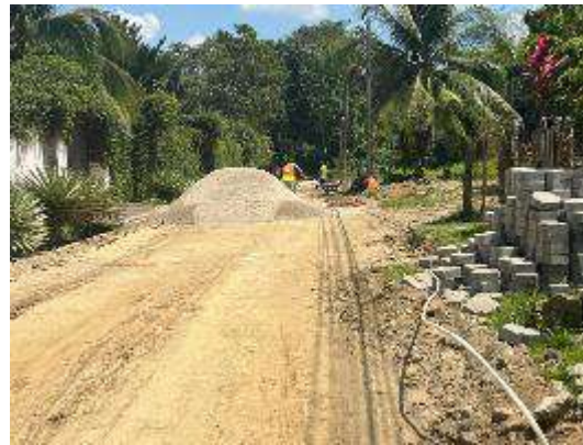
Inspección de construcción de canales y adoquinado de la calle la escondida de Barrio Cienaguita, Sector El Porvenir.
