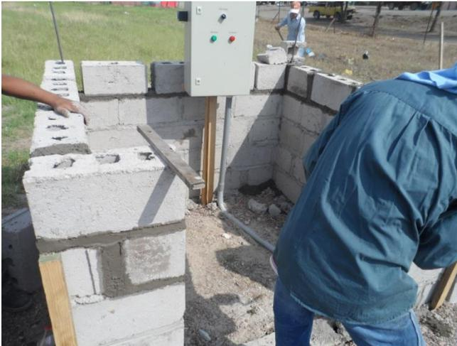
Se concluyó la perforación del pozo y se construyó caseta para resguardar panel de control de bomba.
