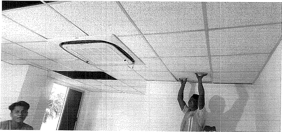
Instalación de cielo falso de fibra mineral
