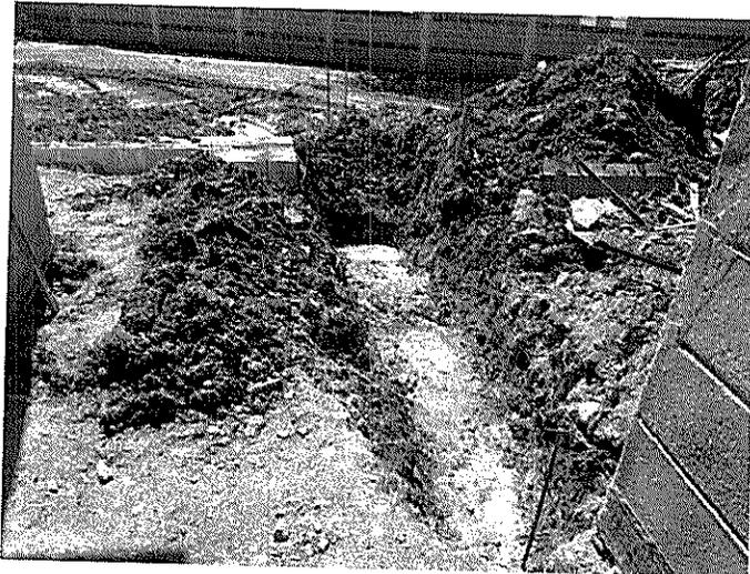
Excavación de cimentación para fundición de zapata en cocina del edificio #2
