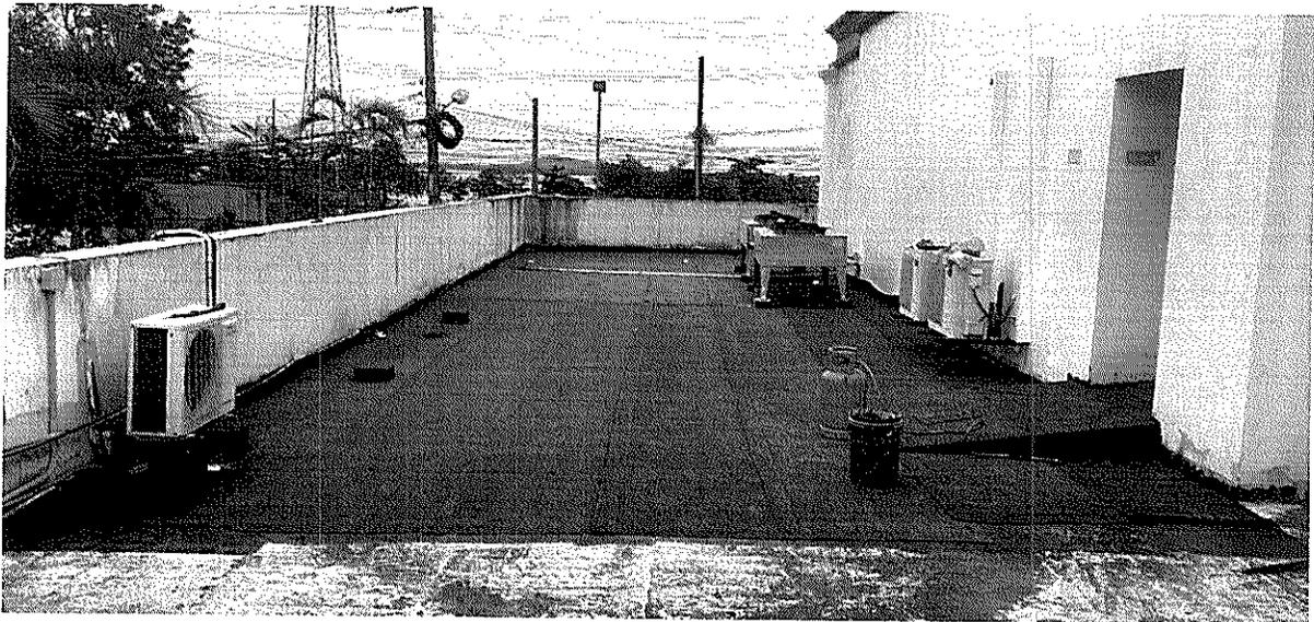
Instalación de membrana asfáltica APP
