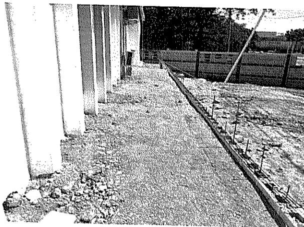
Fundición de muro de retención parte posterior edificio #2
