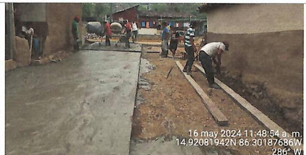
Descripción detallada: Encofrado de tramo a pavimentar
