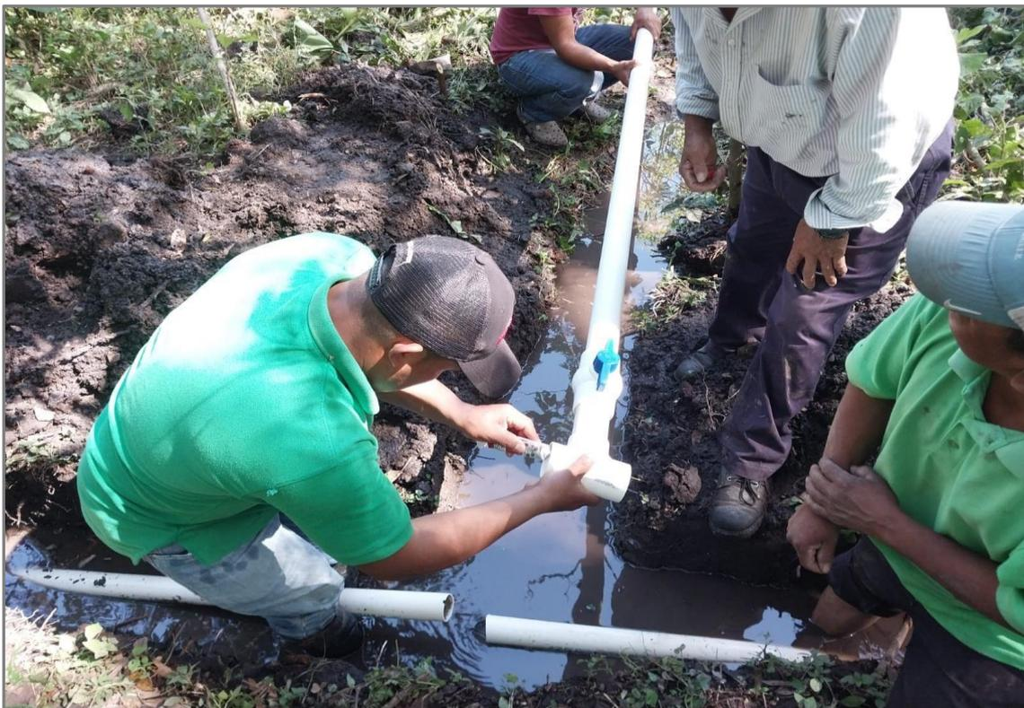
*Ilustración 3. Instalación de válvula de limpieza.*
