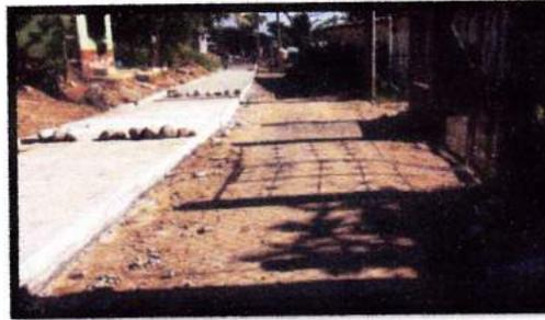
**3.11 Reparacion de Cabezales en Colonia 5 de Abril.** Trazado y marcado, excavacion de material, fundicion de cabezal con mamposteria, relleno de material selecto.
