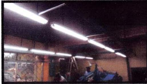
**3.3 Reparación De Iluminación Cancha De Futbol Aldea Manacalito, Sector Ramal De Lima. Consiste en el reemplazo de gabinete de control y protección, acometida eléctrica y cables de alimentación.**
