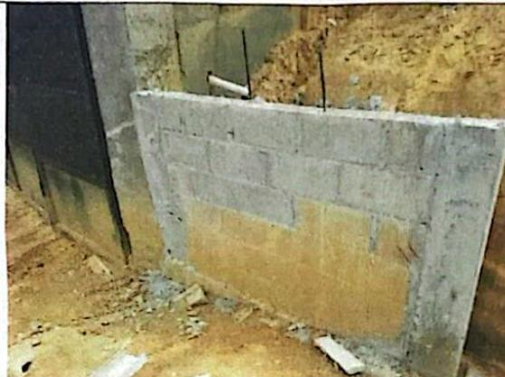
**DESCRIPCIÓN DE ACTIVIDAD:** Muro de bloque simple de 6" sisado, #3milimétrica @ 2 hiladas y una liga de 2cm de espesor con mortero con una proporción de 1:4 .
