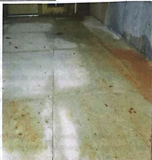
**DESCRIPCIÓN DE ACTIVIDAD:** Concreto de 4000 psi ,e= 15 cms, utilizando grava triturada sin impurezas y arena clasificada ,acero a temperatura #2@50cms a.s. ,aditivo curasol.
