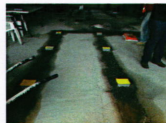
Instalación de cajas eléctricas
