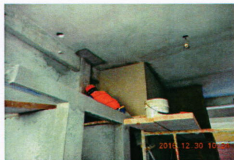
Pulido premezclado en paredes de baño
