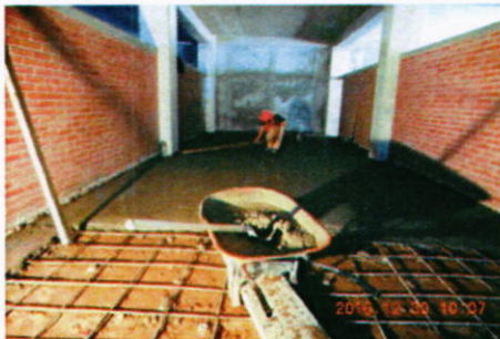
Fundición de firme de concreto
