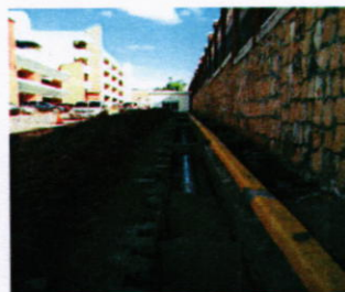
TUBERIA Y MATERIAL SELECTO DE ENCAMADO Y RECUBRIMIENTO
