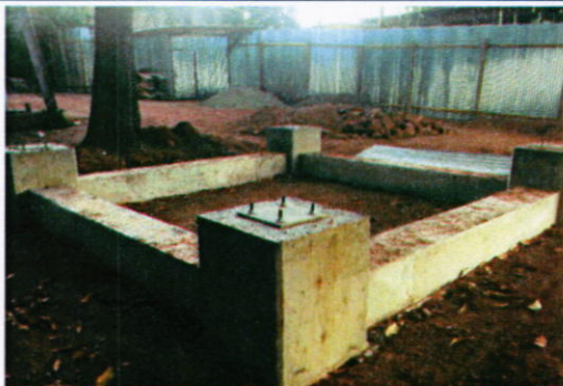
Base para tanque metálico por reubicar.
