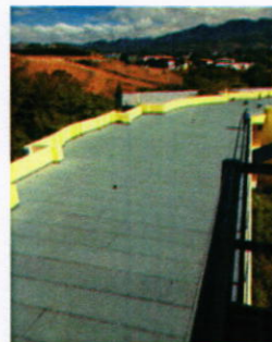
Vista panorámica de Instalación de las membranas impermeabilizantes en azotea 1 y pretilas pintadas
