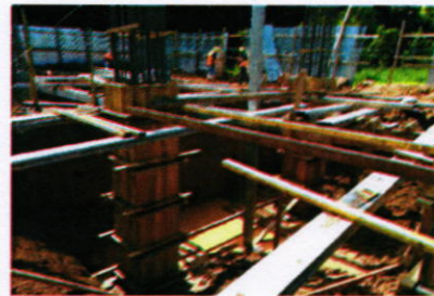
Encofrado de Pedestales de concreto (Grupo Nor-Oeste). 31-01-2017
