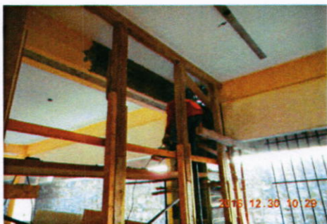
Demolición de viga de rigidez
