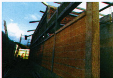
Vista de levantamiento de paredes de bloques de concreto (splitface) en el módulo de desinfección personal (31-01-2017)
