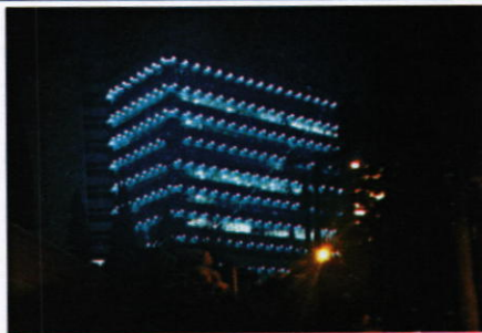
Vista oeste del edificio.
