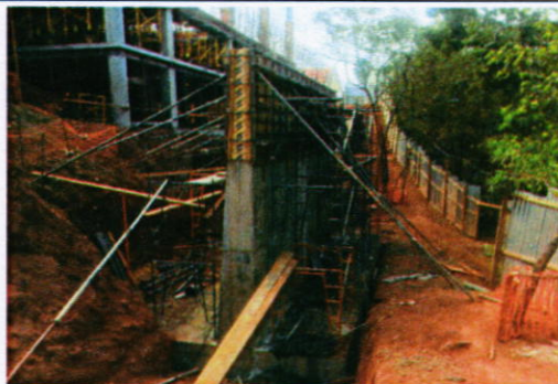
Encofrado de muro de contención en lado oeste.
