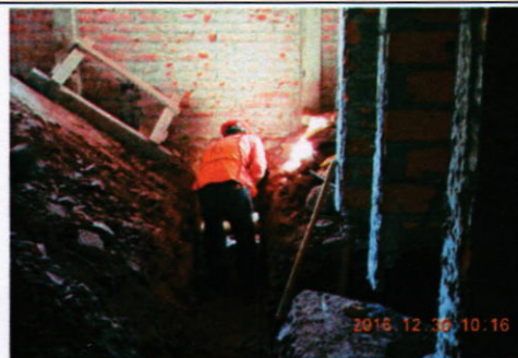
Excavacion para instalación de tuberías de aguas negras en baños
