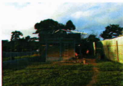
Vista de levantamiento de paredes de bloque de concreto (splitface) en el módulo de desinfección personal (31-01-2017)
