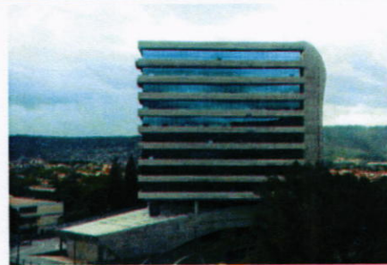
Vista sur-este del edificio.
