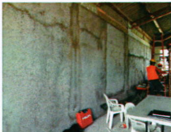
Repello de paredes
