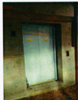
Vista de puerta de cubo de elevador
