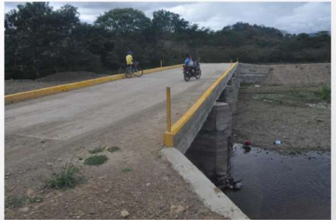
Puente El Zarzal Lps. 1,021,876.87
