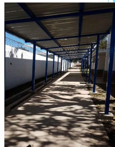
Pasillo hacia módulo de VCM
