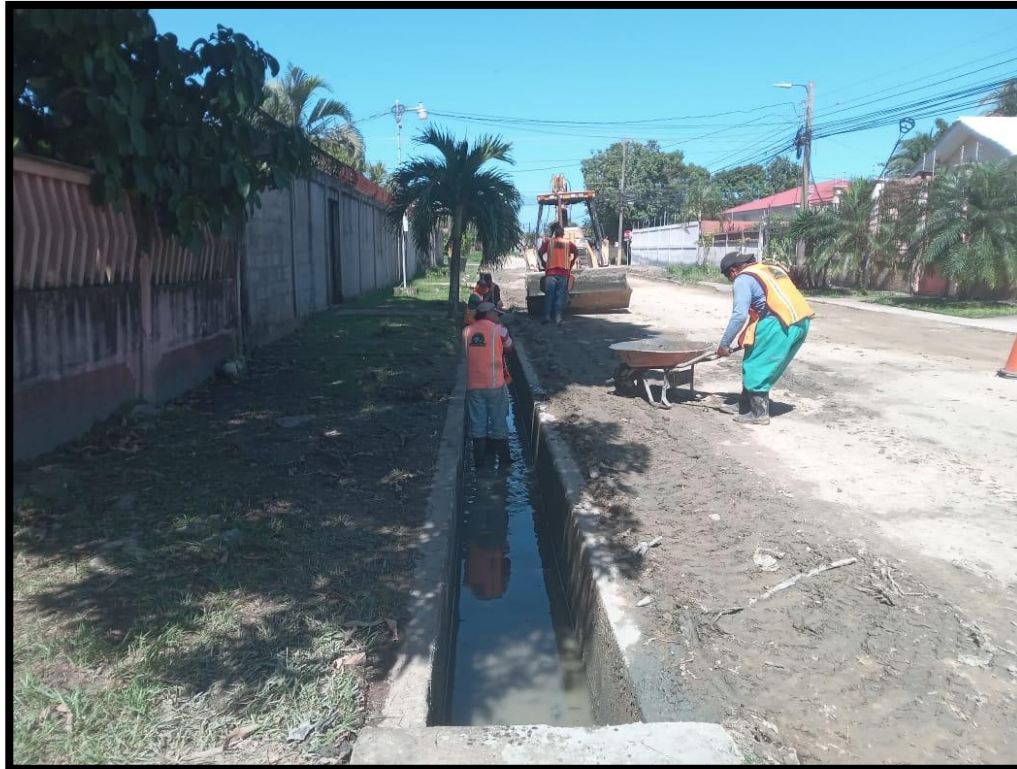
Limpieza de canales pluviales
