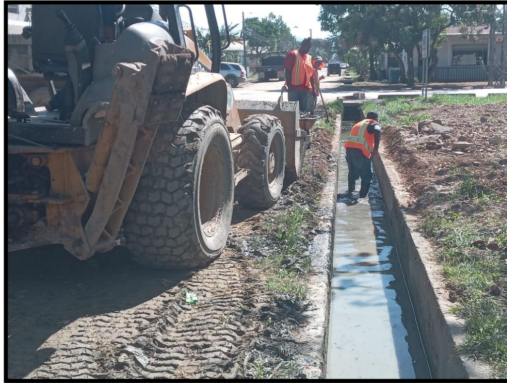
Limpieza de canales pluviales
