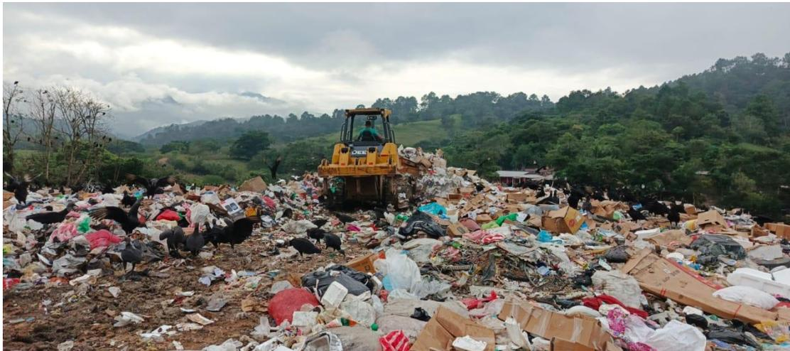
Se aprecia la maquina Bulldozer en trabajos de empuje y soterramiento de basura en el relleno sanitario, barrio El Copante, La Entrada, Nueva Arcadia, Copán.
