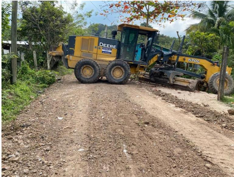
Se observa a la motoniveladora en trabajos de escarificado, conformación, cuneteo y vibrado de calles de la aldea de San Pablo del Roble.
