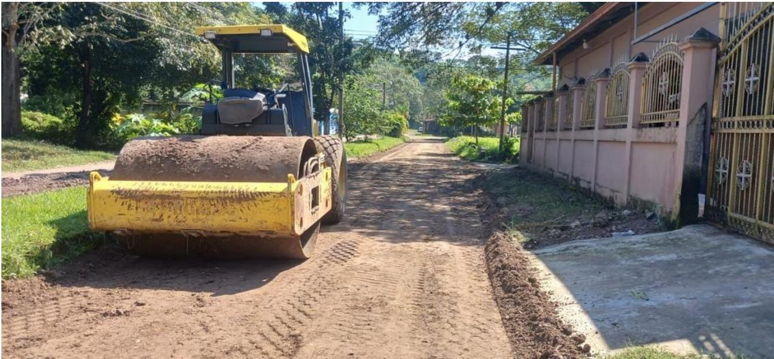
Motoniveladora y vibro compactador en escarificado, conformación, cuneteo y vibrado de calles de la colonia Villa Bosques.
