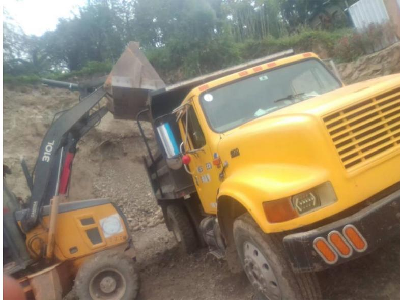
Se observa a la maquina Retro Excavadora 310L en corte y carga de material selecto.
