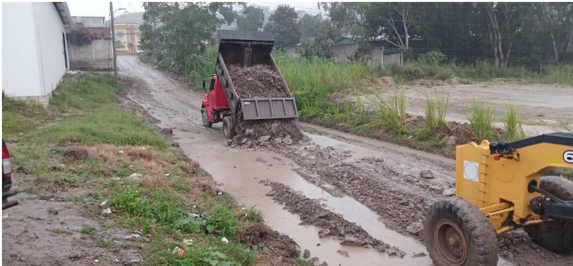
Se aprecia trabajos de escarificado, conformación, cuneteo y vibrado de calles en la colonia 15 de Septiembre.
