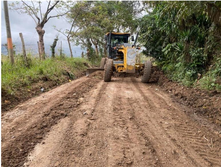
Motoniveladora y vibro compactador en escarificado, conformación, cuneteo y vibrado de calles en la aldea Los Pozos.
