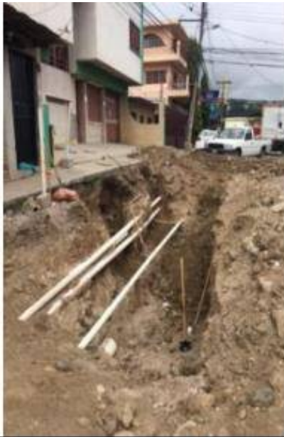
Suministro y colocación tubería PVC 8" RD 41 para el colector principal.
