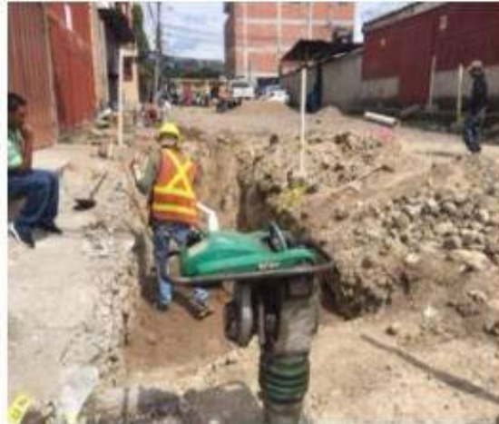
Suministro y colocación tubería PVC 8" RD 41 para el colector principal.
