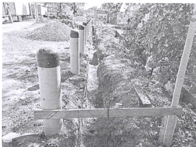
Excavación de cimentación
