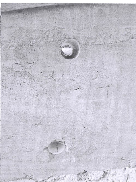
Instalación de drenajes
