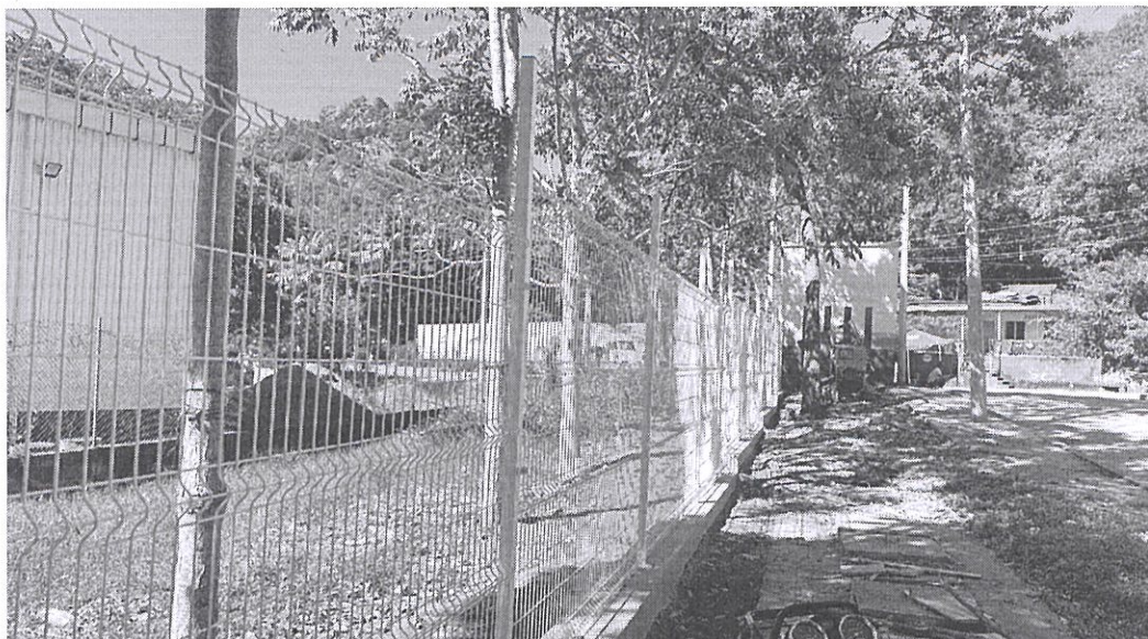
Aduana El Florido, cerco de malla instalado.
