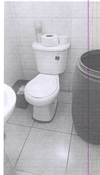
Aduana El Poy, instalación de sanitarios y lavamanos.
