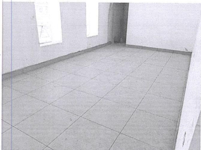
Instalación de piso de porcelanato
