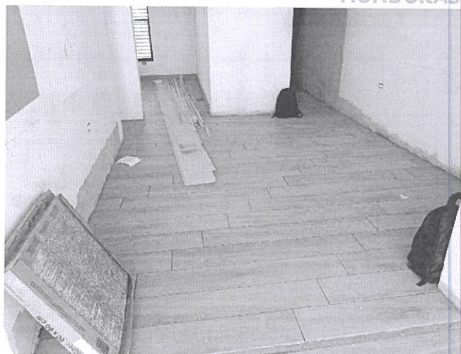
Instalación de piso de cerámica
