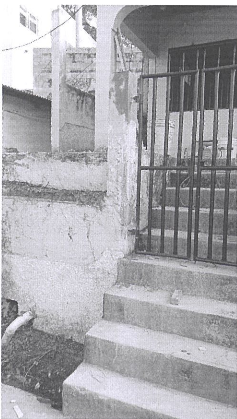
Aduana Agua Caliente, portón de acceso instalado y pintado.
