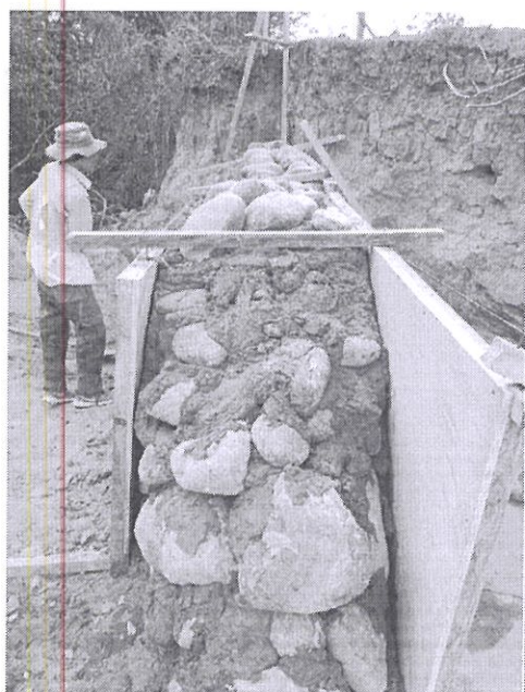
Construcción de muro de mampostería
