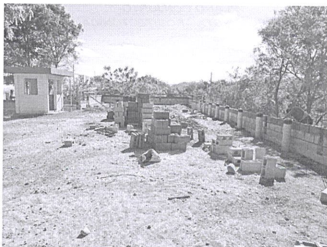
Construcción de muro perimetral
