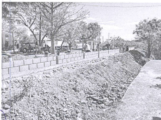
Construcción de muro perimetra
