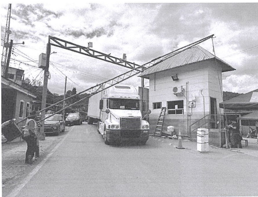
Aduana Agua Caliente, instalación de cuatro plumas electrónicas.
