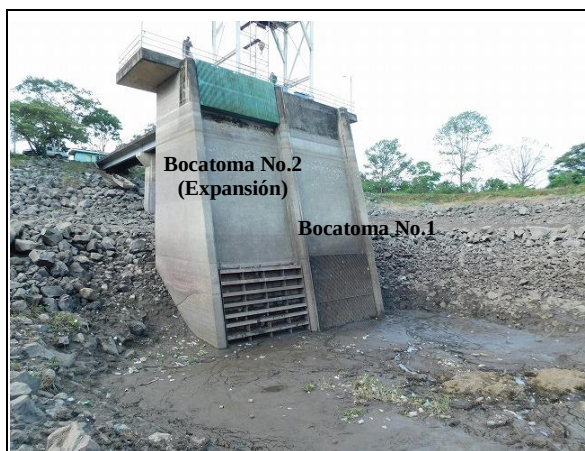
Estructura de Bocatoma de Cañaveral Puente de acceso (Ancho=3m) y estructura de bocatoma
