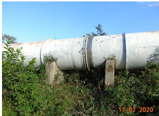
Penstock No. 2 de la C.H. Río Lindo (Junta de expansión No.7 entre los soportes 600 y 601)
