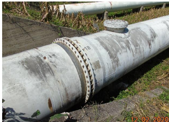
Penstock No. 1 de la C.H. Río Lindo (Junta de expansión No.18 entre los soportes 1700 y 1701)
