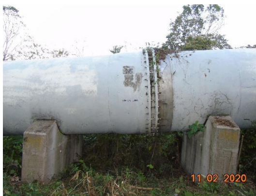
Penstock No. 2 de la C.H. Río Lindo (Junta de expansión No.15 entre los soportes 1408 y 1409)
