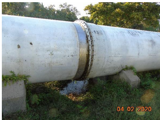
Penstock No. 1 de la C.H. Río Lindo (Junta de expansión No.15 entre los soportes 1400 y 1401)
