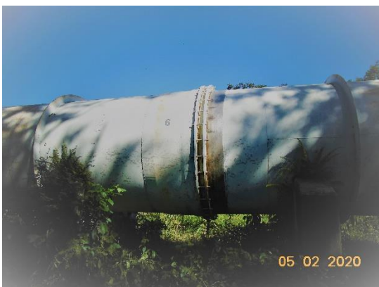
Penstock No. 2 de la C.H. Río Lindo (Junta de expansión No.8 entre los soportes 707 y 708)
