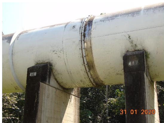
Tubería Presurizada No. 1 de la C.H. Río Lindo (Junta de expansión No.5 entre los soportes 417 y 418)
