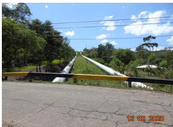
A la izquierda: Penstock No.2 anclaje FP18 y a la derecha: Penstock No.1 anclaje FP20 Vista hacia la Central Río Lindo
