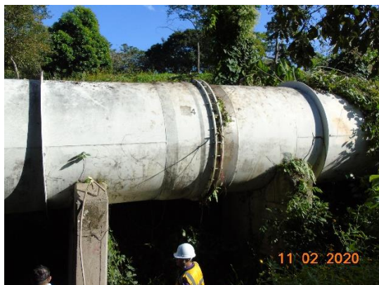
Penstock No. 2 de la C.H. Río Lindo (Junta de expansión No. 6 entre los soportes 515 y 516)
