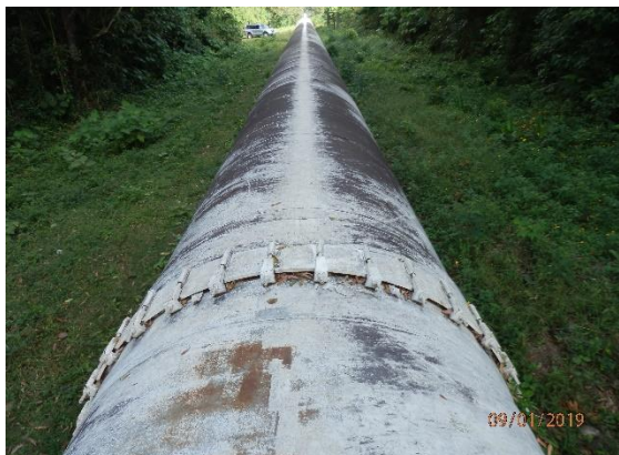
Penstock de la Central Hidroeléctrica Cañaverl (Anclaje de Concreto No.2 vista hacia Punto Alto)
