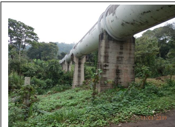
Tubería Aguas Arriba No. 1 para la Central Hidroeléctrica Río Lindo (Vista desde el Túnel hacia anclaje FP3)
