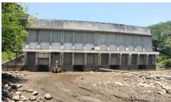
Estructura de Desfogue de Río Lindo (Salida del Foso de Descarga)
