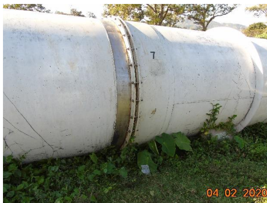
Penstock No. 1 de la C.H. Río Lindo (Junta de expansión No. 9 entre los soportes 813 y 814)
