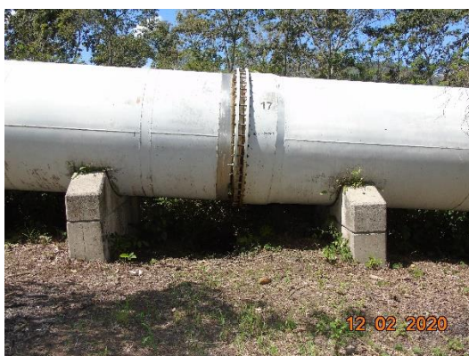
Penstock No. 1 de la C.H. Río Lindo (Junta de expansión No.17 entre los soportes 1608 y 1609)
