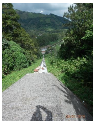
Penstock de la Central Hidroeléctrica Cañaverl
