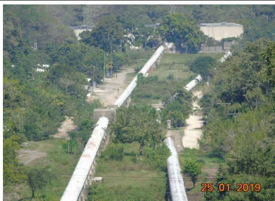
Penstock No.2 . Al fondo se aprecia el anclaje FP5. Vista desde el anclaje FP4
