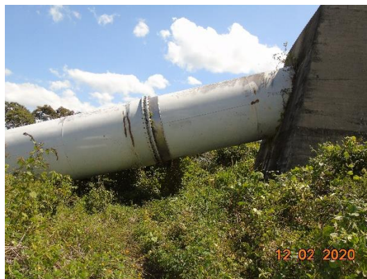
Penstock No. 1 de la C.H. Río Lindo (Junta de expansión No.18 entre los soportes 1700 y 1701)
