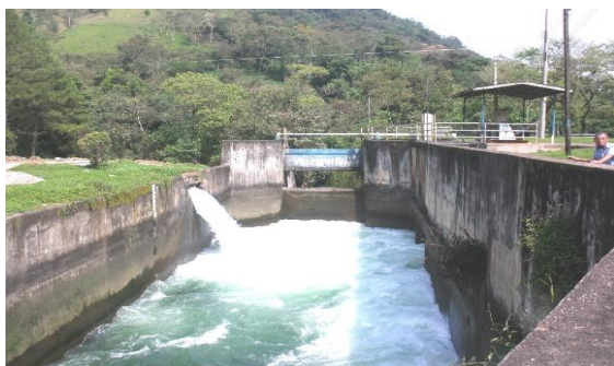
Estructura de Control de Río Lindo (Compuerta de Aliviadero)
