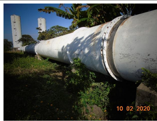
Tubería Presurizada No. 2 de la C.H. Río Lindo (Junta de expansión No.3 entre los soportes 213 y 214)
