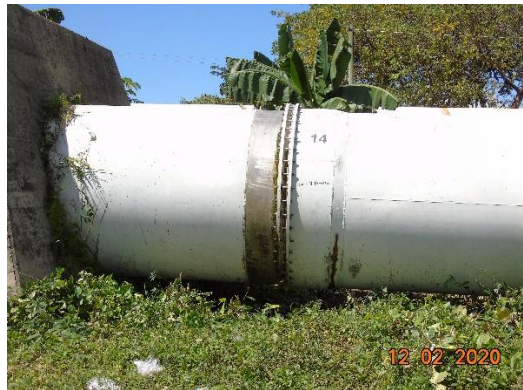
Penstock No. 1 de la C.H. Río Lindo (Junta de expansión No.16 entre los soportes 1501 y 1502)
