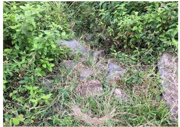
(Enrocado del talud aguas-arriba de la presa)
