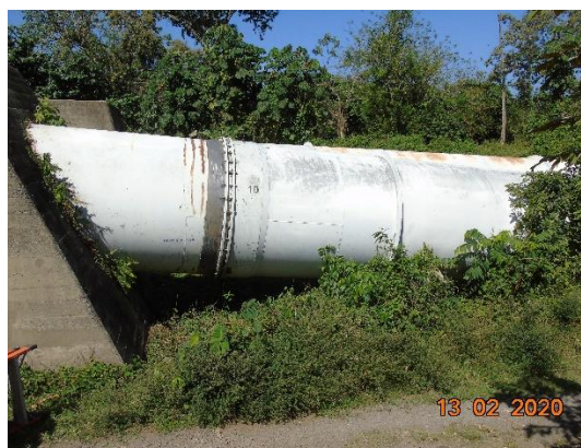
Penstock No. 1 de la C.H. Río Lindo (Junta de expansión No. 12 entre los soportes 1106 y 1107)
