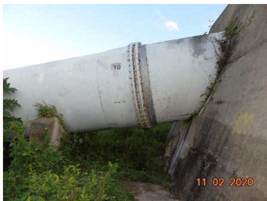
Penstock No. 2 de la C.H. Río Lindo (Junta de expansión No.12 entre los soportes 1100 y 1101)
