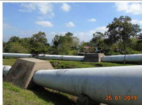
Penstock No.2 . Vista desde el anclaje FP5. Vista hacia el anclaje FP4
