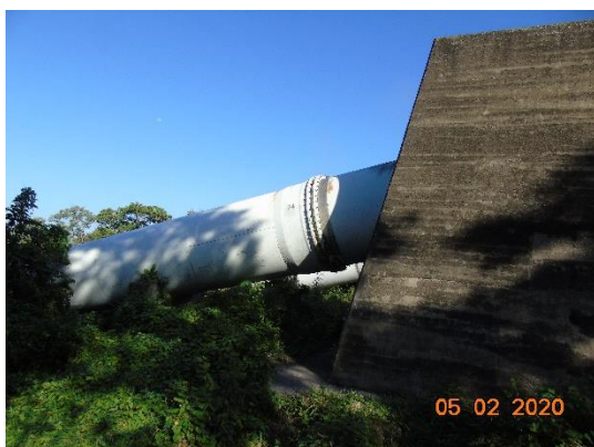
Penstock No. 2 de la C.H. Río Lindo (Junta de expansión No.14 entre los soportes 1300 y 1301)
