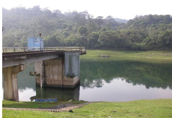
Estructura de Bocatoma de Río Lindo (Estructura del Puente y Pasamanos)
