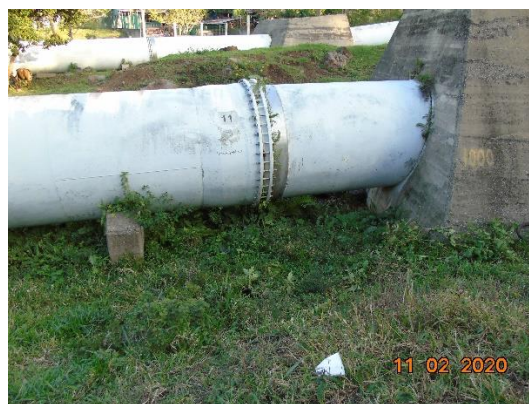
Penstock No. 2 de la C.H. Río Lindo (Junta de expansión No.13 entre los soportes 1200 y 1201)
