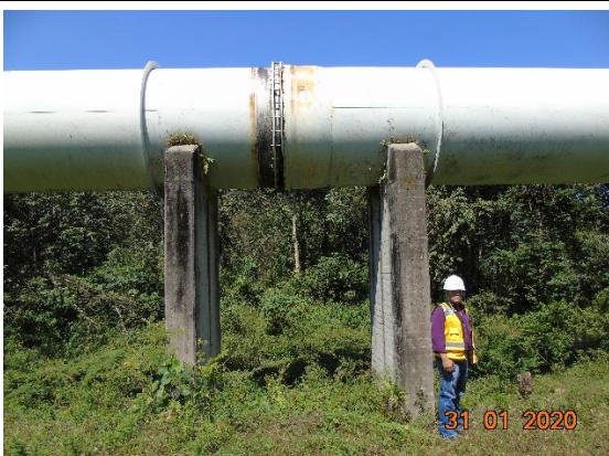
Tubería Presurizada No. 2 de la C.H. Río Lindo (Junta de expansión No.2 entre los soportes 116 y 117)
