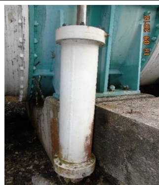
Válvula de venteo en Posición Cerrada
