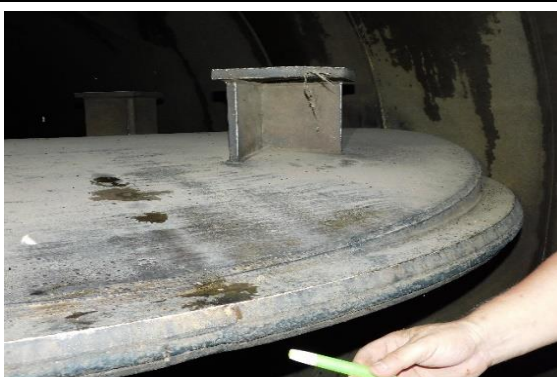
El lápiz señala el empaque del disco de la válvula
