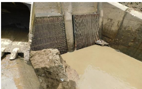
Estructura de Bocatoma de Río Lindo (Mampara y Pasamanos)
