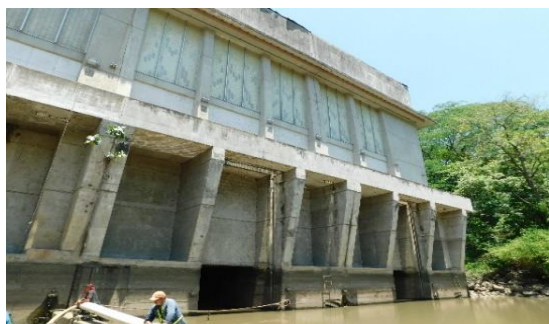
Estructura de Desfogue de Río Lindo (Salida del Foso de Descarga)
