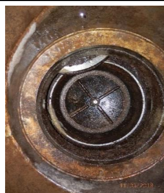
Válvula de venteo en Posición Cerrada
