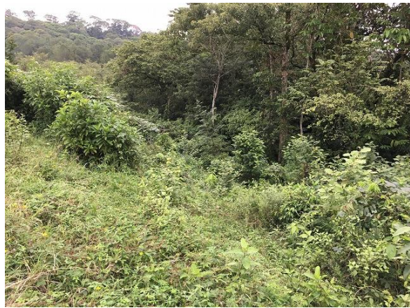
(Talud aguas-abajo de la presa)
