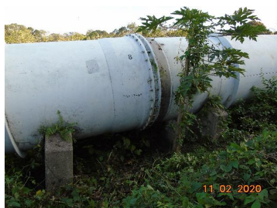
Penstock No. 2 de la C.H. Río Lindo (Junta de expansión No.8 entre los soportes 707 y 708)
