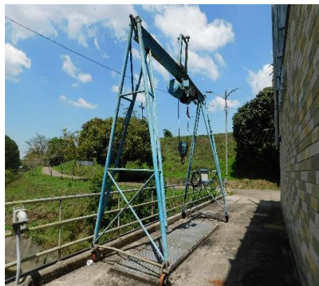
Estructura de Desfogue de Cañaverál (Grúa Móvil Tipo Pórtico)
