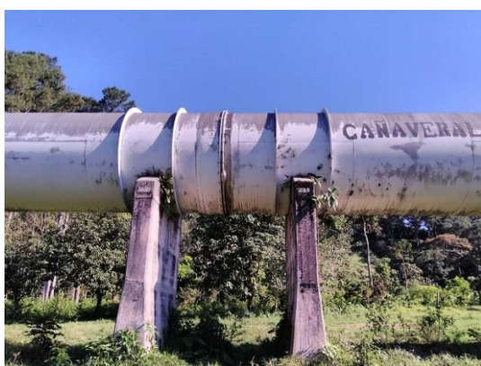
Junta de montaje ( dresser )
