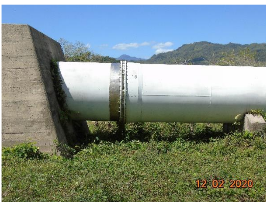
Penstock No. 1 de la C.H. Río Lindo (Junta de expansión No.17 entre los soportes 1608 y 1609)
