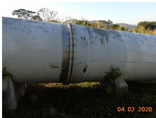
Penstock No. 1 de la C.H. Río Lindo (Junta de expansión No. 12 entre los soportes 1106 y 1107)
