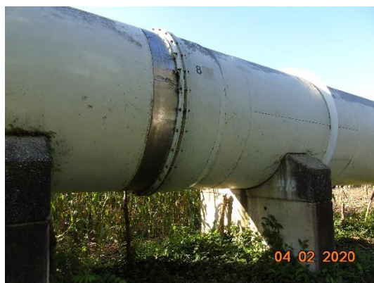
Penstock No. 1 de la C.H. Río Lindo (Junta de expansión No. 10 entre los soportes 900 y 901)
