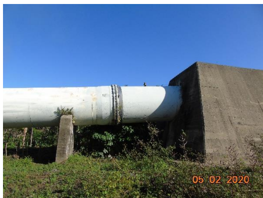
Penstock No. 2 de la C.H. Río Lindo (Junta de expansión No.14 entre los soportes 1300 y 1301)
