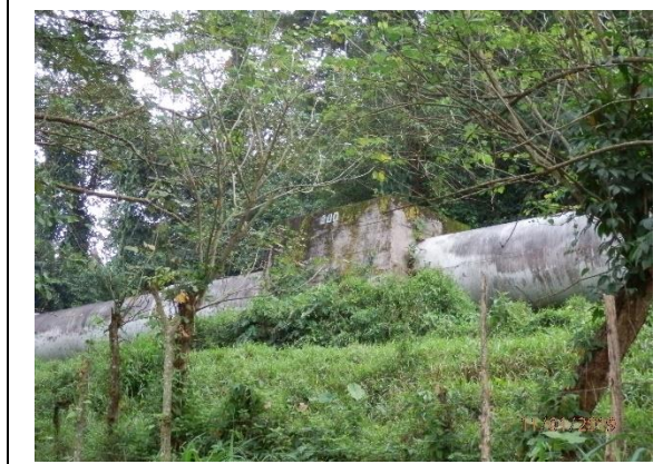
(8) Tuberías Presurizadas y Torres de Oscilación de la Central Hidroeléctrica Río Lindo
