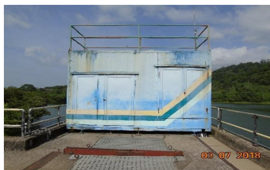
Compuertas de Bocatoma de Río Lindo (Gabinete de Control Electrohidráulico para Exteriores)
