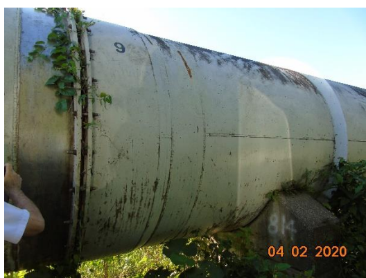
Penstock No. 1 de la C.H. Río Lindo (Junta de expansión No. 11 entre los soportes 1021 y 1022)
