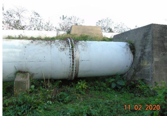
Penstock No. 2 de la C.H. Río Lindo (Junta de expansión No.15 entre los soportes 1408 y 1409)
