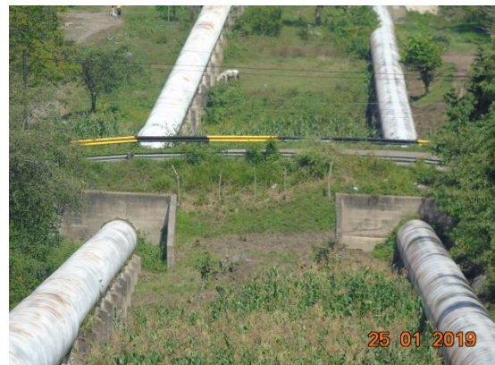
Torres de Oscilación: A la derecha: Torre No.1 y a la izquierda: Torre No.2 Vista hacia la Central Río Lindo
