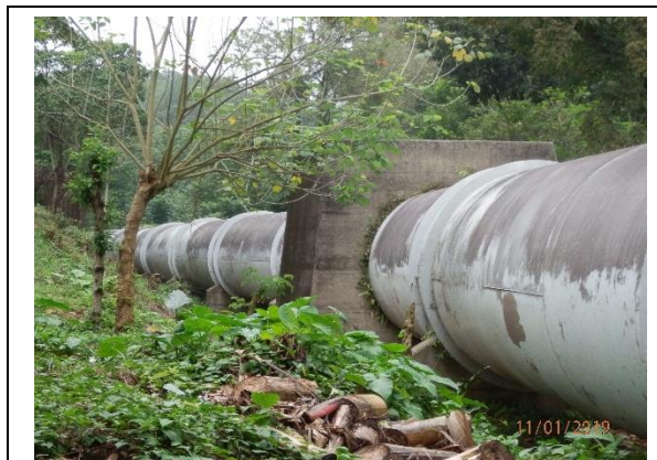
Tubería Aguas Arriba No. 1 para la Central Hidroeléctrica Río Lindo (Anclaje FP3)
