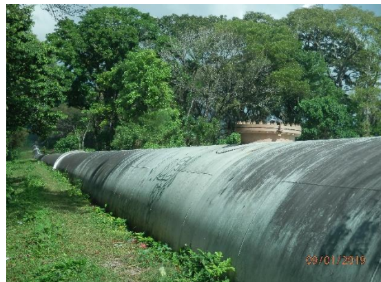
Penstock de la Central Hidroeléctrica Cañaverl (Vista desde Punto Alto hacia Bocatoma)
