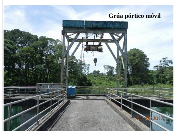
Estructura de Bocatoma de Cañaveral Polipasto para compuerta de bocatoma
