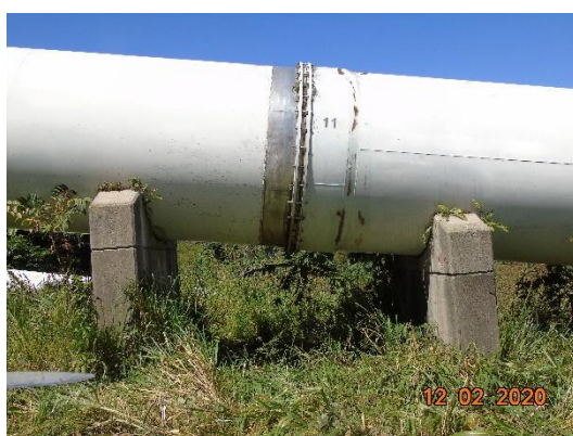
Penstock No. 1 de la C.H. Río Lindo (Junta de expansión No. 11 entre los soportes 1021 y 1022)
