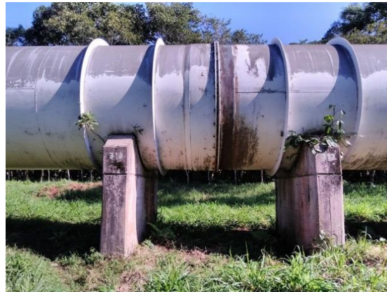
Tubería aguas-arriba de Río Lindo (Junta de expansión No.4, entre los soportes 313 y 314)
