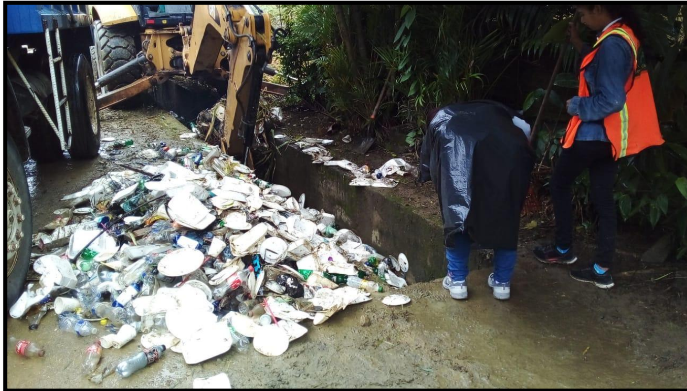
Recolección de desechos generados por limpieza de canales pluviales
