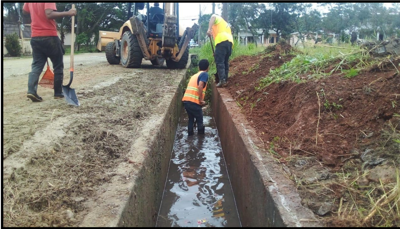
Limpieza de canales pluviales
