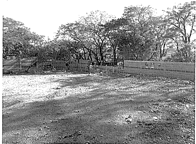
Construcción de muro perimetral
