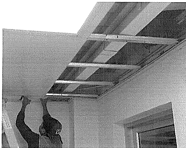
Instalación de canal de PVC
