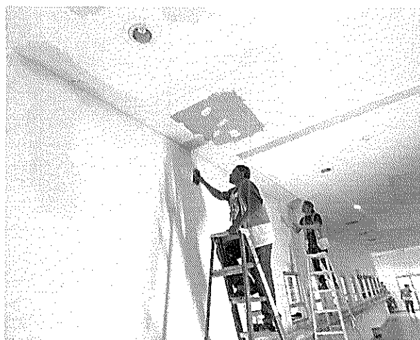
Instalación de cielos falso de tabla yeso
