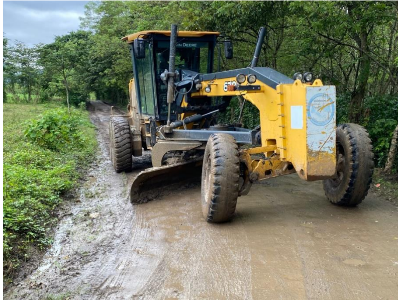
Motoniveladora y vibro compactador en escarificado, conformación, cuneteo y vibrado de calle en aldea Santa Luz.
