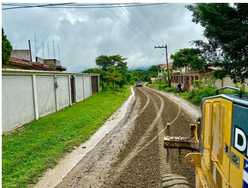
Trabajos de escarificado, conformación, cuneteo y vibrado de calles en barrio El Dorado.
