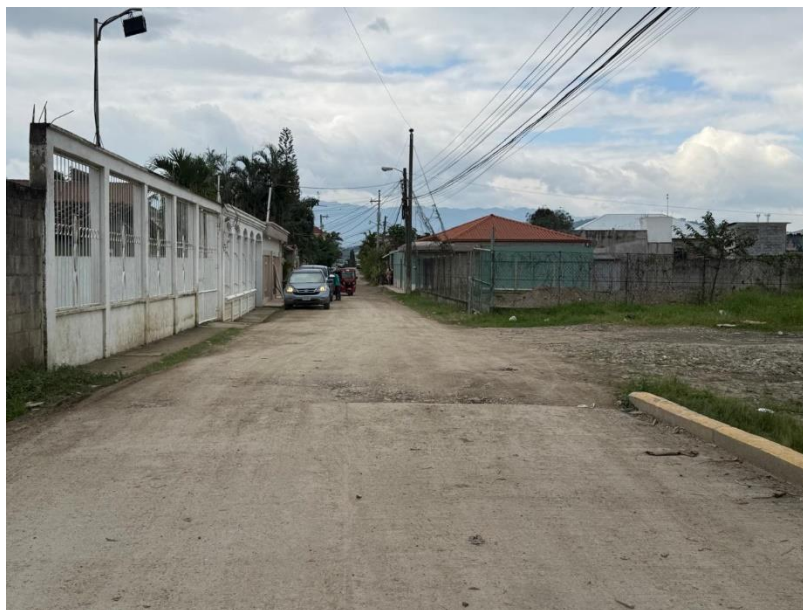
Proyecto pavimentación acceso a colonia Vanessa, calle posterior a mercado El Predio, La Entrada, Nueva Arcadia, Copan.
