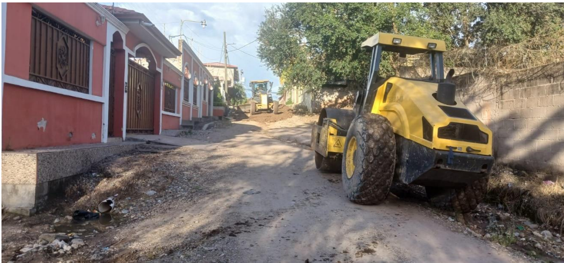
Motoniveladora y vibro compactador en escarificado, conformación, cuneteo y vibrado de calles en colonia Miravalle.
