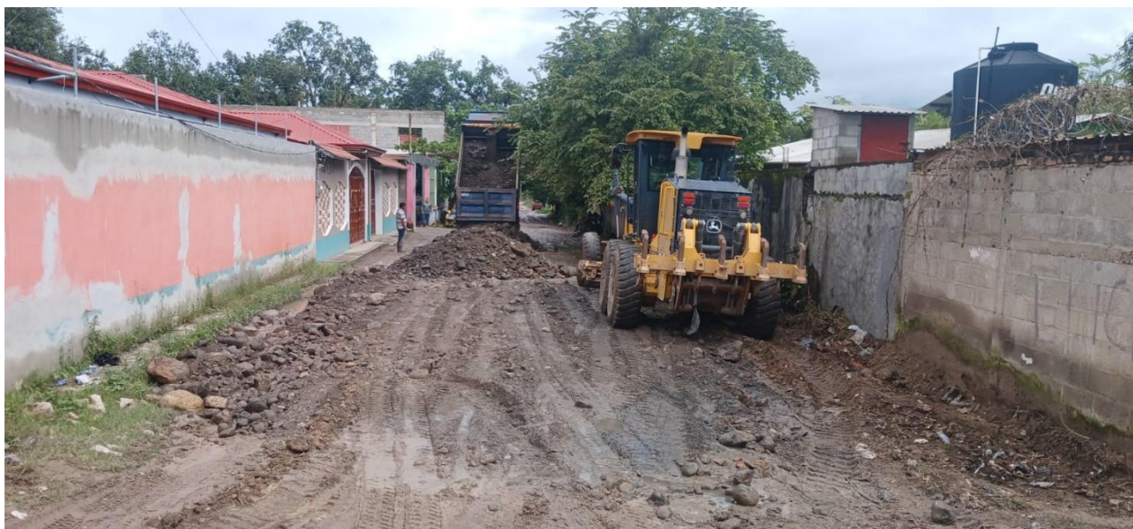
Motoniveladora y vibro compactador en escarificado, conformación, cuneteo y vibrado de calles en barrio El Dorado.
