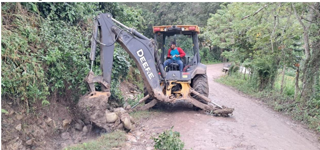
Retro Excavadora 310L trabajo de habilitación de un tramo de calle que le da acceso a la aldea de San Pablo del Roble.
