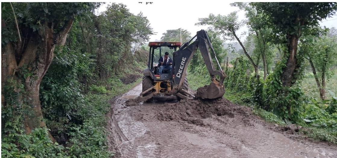
Retro Excavadora 310L trabajo de habilitación de un tramo de calle que le da acceso a la aldea de San Pablo del Roble.
