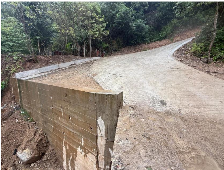
Proyecto finalizado de pavimentación con concreto hidráulico Camino Productivo tramo aldea Chalmeca-aldea Las Conchas, Nueva Arcadia, Copán.
