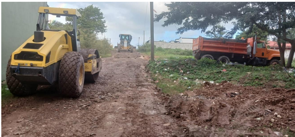
Motoniveladora y vibro compactador en escarificado, conformación, cuneteo y vibrado de calles en colonia Miravalle.
