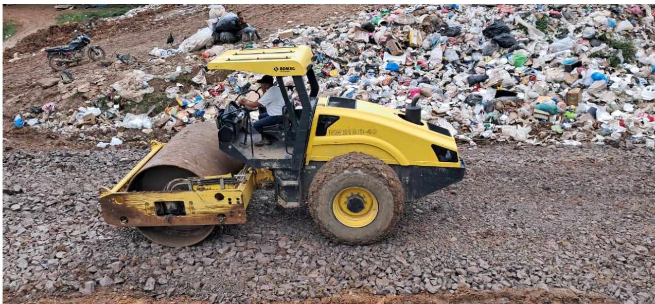
Tractor y vibro compactador en escarificado, conformación, cuneteo y vibrado de calle que conduce hacia el relleno sanitario.
