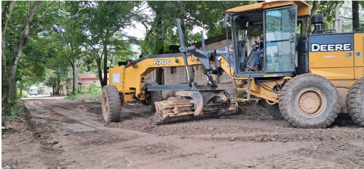
Motoniveladora y vibro compactador en escarificado, conformación, cuneteo y vibrado de calles en colonia Villa Bosques.
