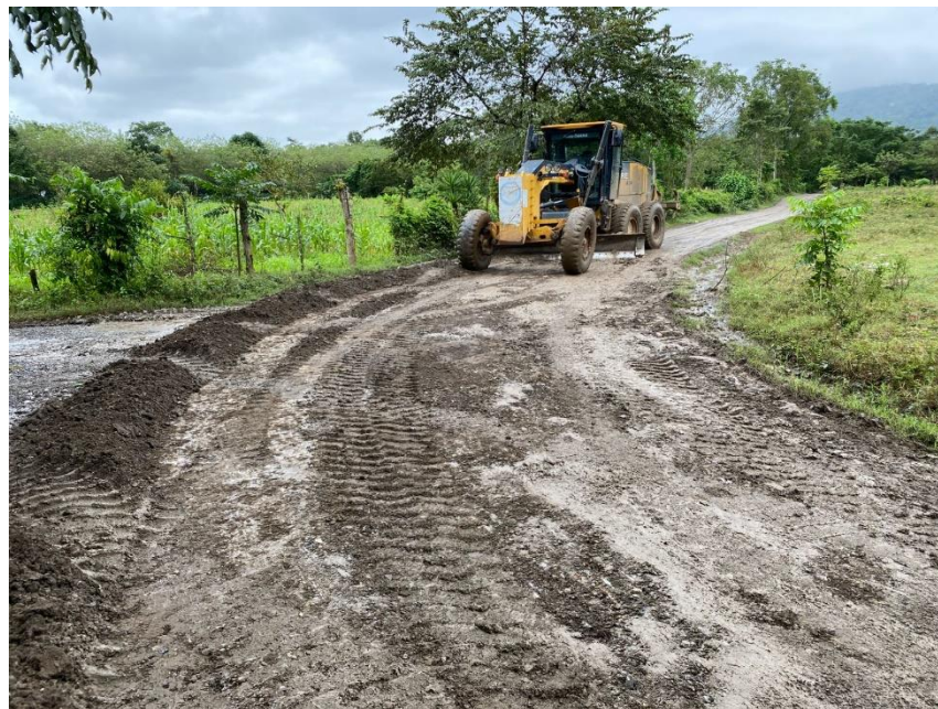
Motoniveladora y vibro compactador en escarificado, conformación, cuneteo y vibrado de calle en aldea Santa Luz.
