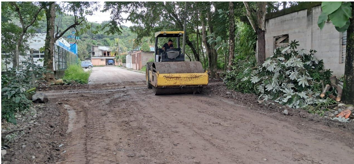
Motoniveladora y vibro compactador en escarificado, conformación, cuneteo y vibrado de calles en colonia Villa Bosques.
