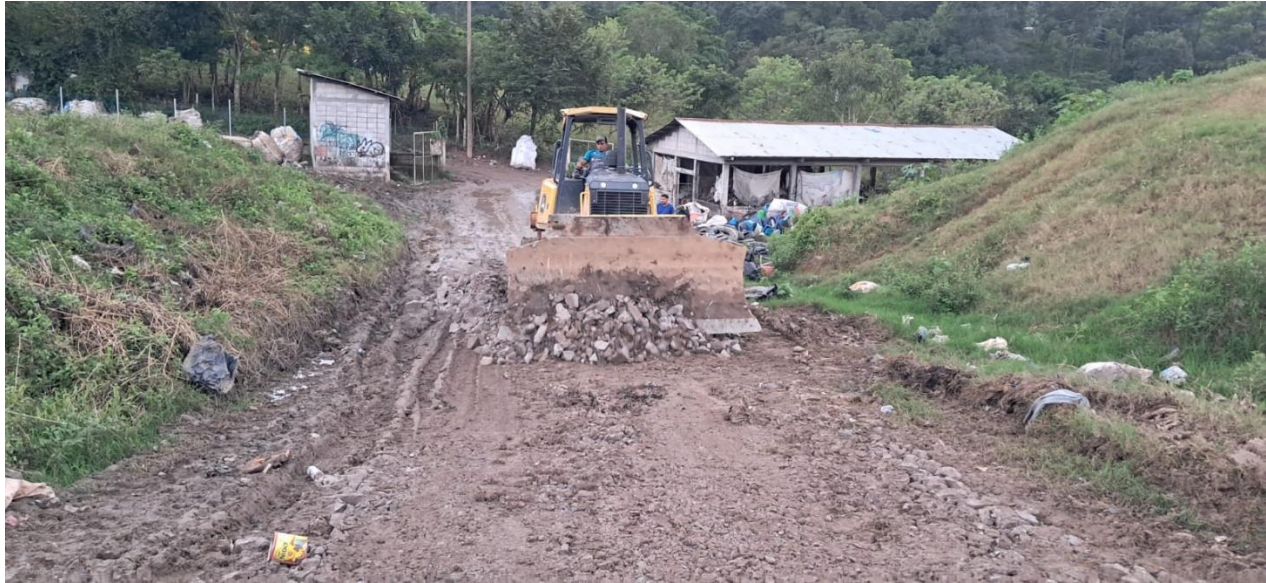
Tractor y vibro compactador en escarificado, conformación, cuneteo y vibrado de calle que conduce hacia el relleno sanitario.
