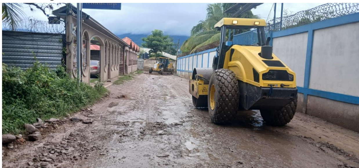
Motoniveladora y vibro compactador en escarificado, conformación, cuneteo y vibrado de calles en barrio El Dorado.
