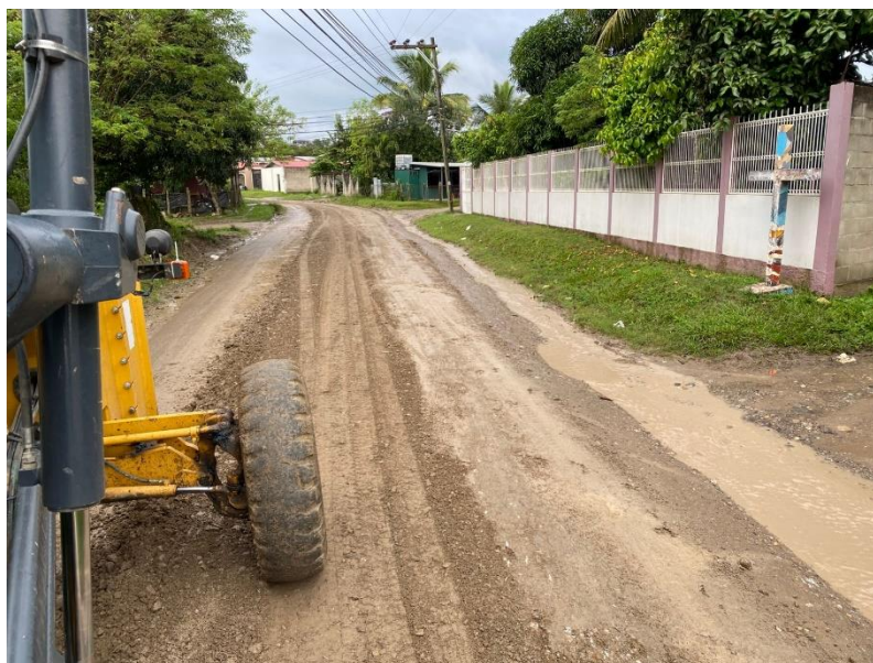
Trabajos de escarificado, conformación, cuneteo y vibrado de calles en barrio El Dorado.
