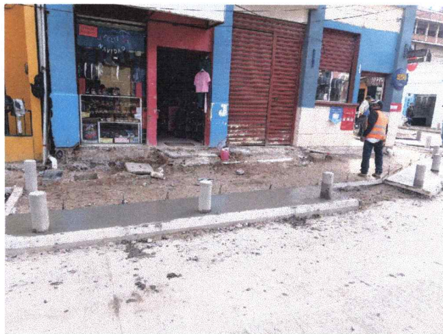
Junto a Casa Moda falta bolardos y rejillas
