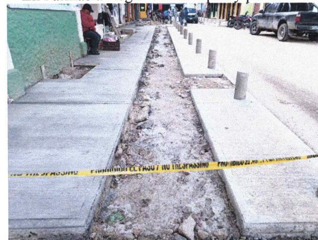
En Farmacia Regis falta adoquín y podotáctil
