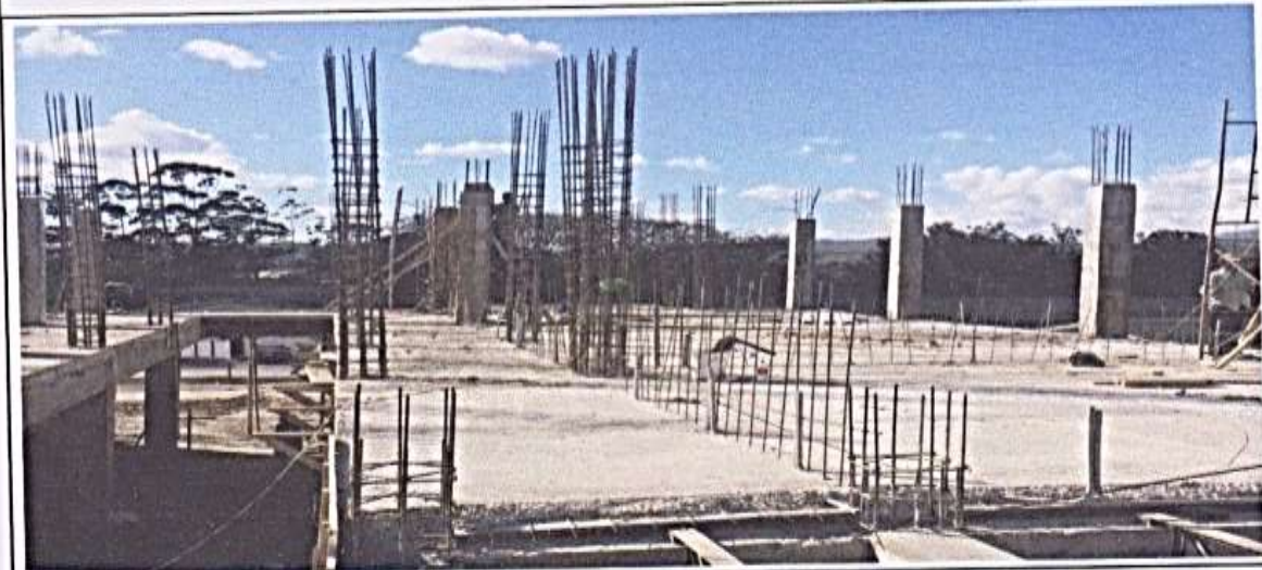
Fundición de Losa de concreto de 8cm espesor con malla electrosoldada incluye lamina Galvadeck calibre 24
