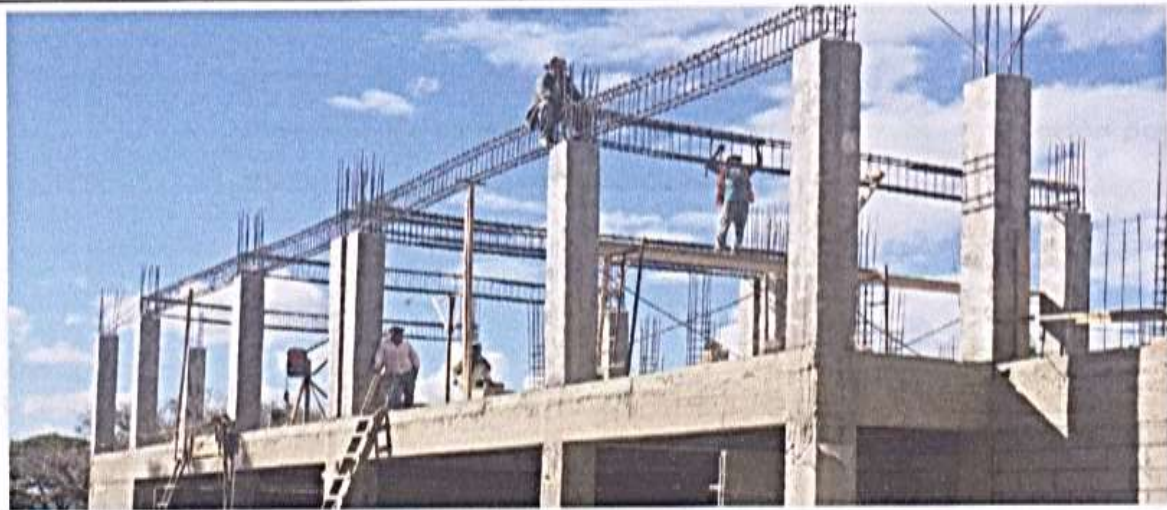
Armado de Vigas V-2 en Azotea
