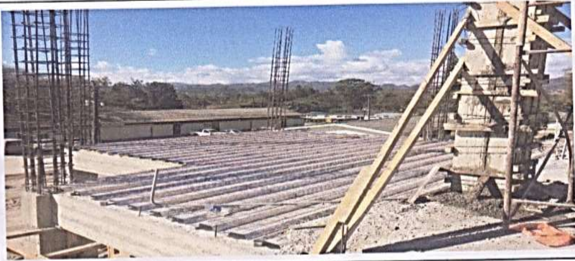
Armado de Losa de concreto de 8cm espesor con malla electrosoldada incluye lamina Galvadeck calibre 24
