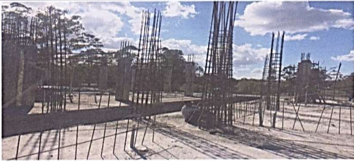
Armado Y colocación de Castillos
