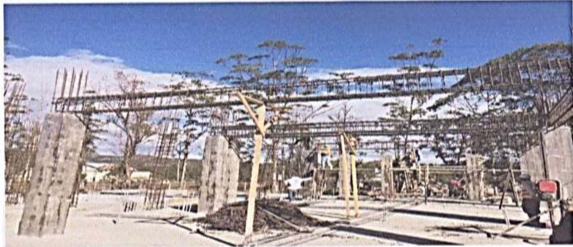
Armado de Vigas V-1 en Azotea
