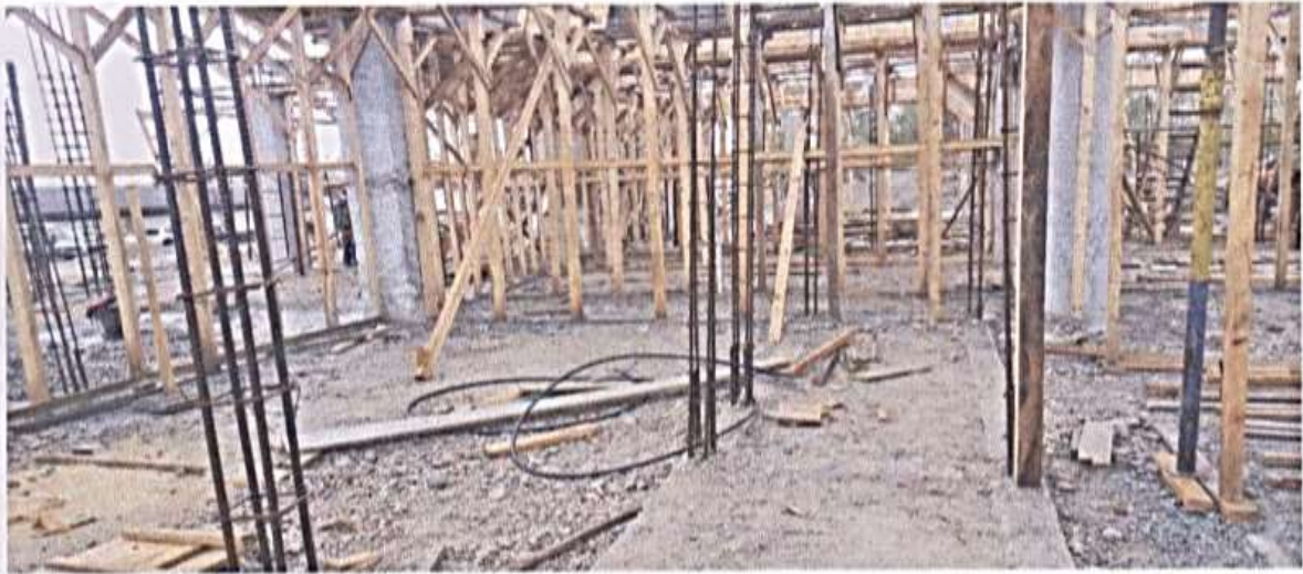
Armado Y colocación de Castillos
