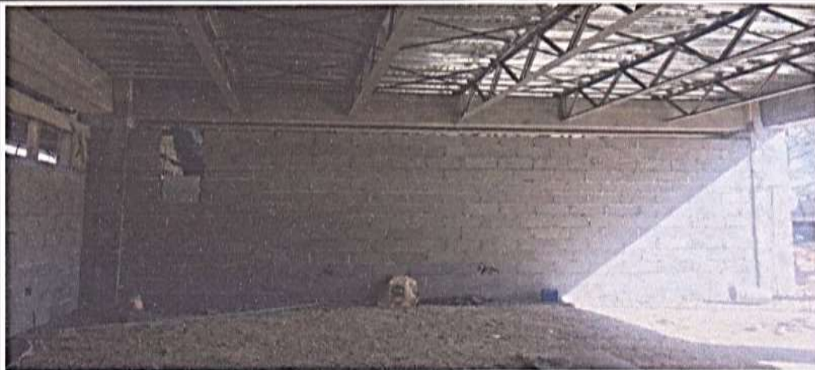
Colocación de bloque de 4" con bastoneado, fundido con concreto 2500PSI
