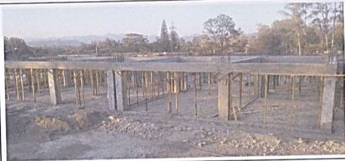
Se terminó de fundir las Vigas V-1 en losa de Segundo Nivel
