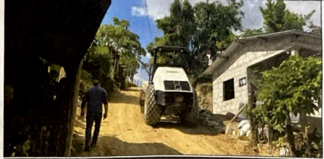
MANTENIMIENTO Y REPARACION DE CALLE SECTOR EL CHORIZO
