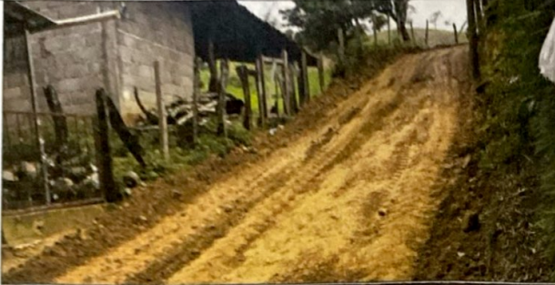
MANTENIMIENTO Y REPARACION DE CALLE SECTOR EL CHORIZO
