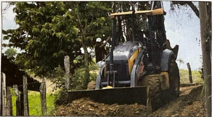
MANTENIMIENTO Y REPARACION DE CALLE SECTOR EL CHORIZO
