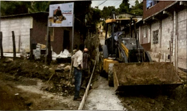
MANTENIMIENTO Y REPARACION DE CALLE SECTOR EL CHORIZO
