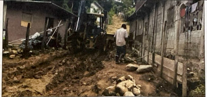
MANTENIMIENTO Y REPARACION DE CALLE SECTOR EL CHORIZO
