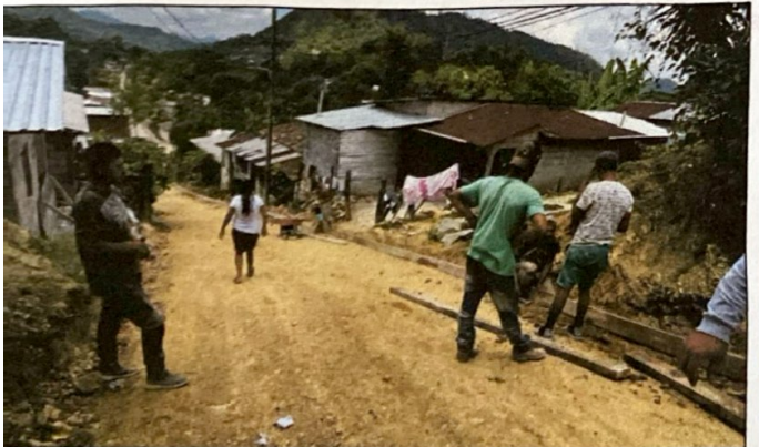
MANTENIMIENTO Y REPARACION DE CALLE SECTOR EL CHORIZO
