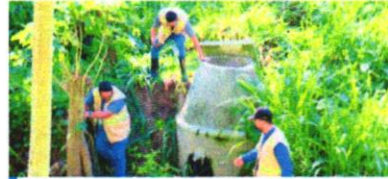
Representantes de la Gerencia de Ambiente de la Municipalidad de San Pedro Sula, de la Fiscalía de Protección al Medio Ambiente y la Procuraduría General de la República (PGR), inspeccionaron ayer la zona de contaminación.
