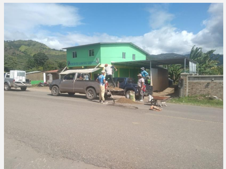
Bacheo tramo del corredor agrícola
