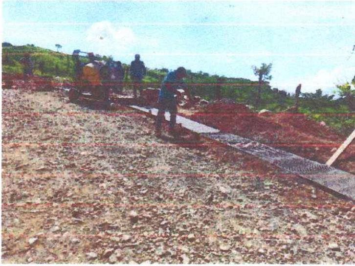
Fabricación y fundición de concreto ciclópeo  $e=0.20$  m relación 1:2:3 mezclado en mezcladora con capacidad de 1 saco.
