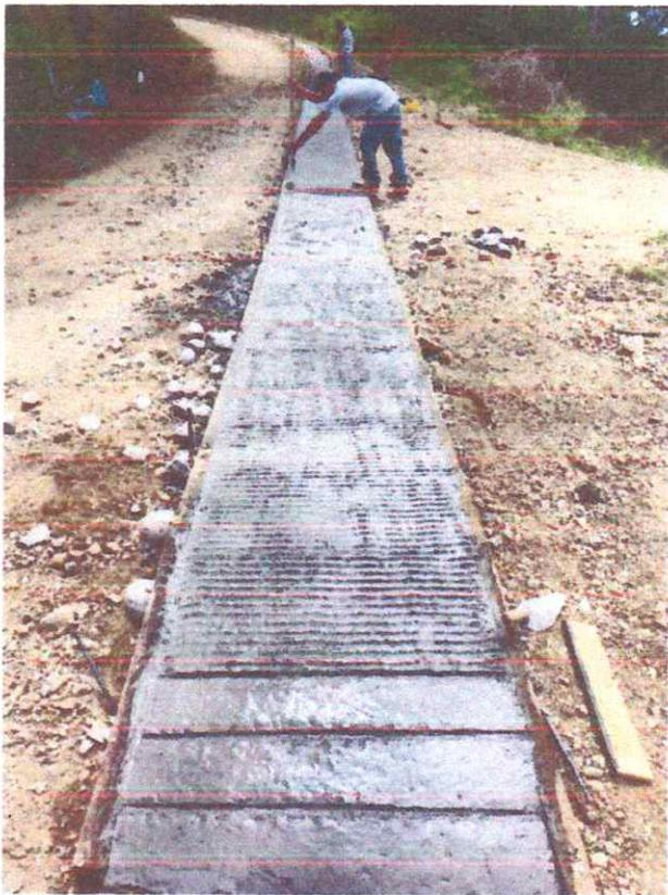
Desencofrado de concreto ciclópeo (Se permite el curado de 21 días antes del tráfico vehicular).
