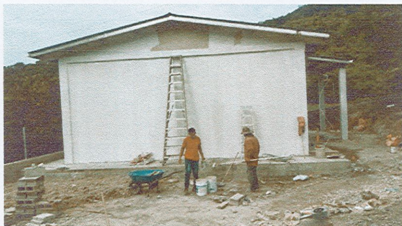
INTERVENCION DE INFRAESTRUCTURA ESCOLAR Lps. 3,300,000.00
