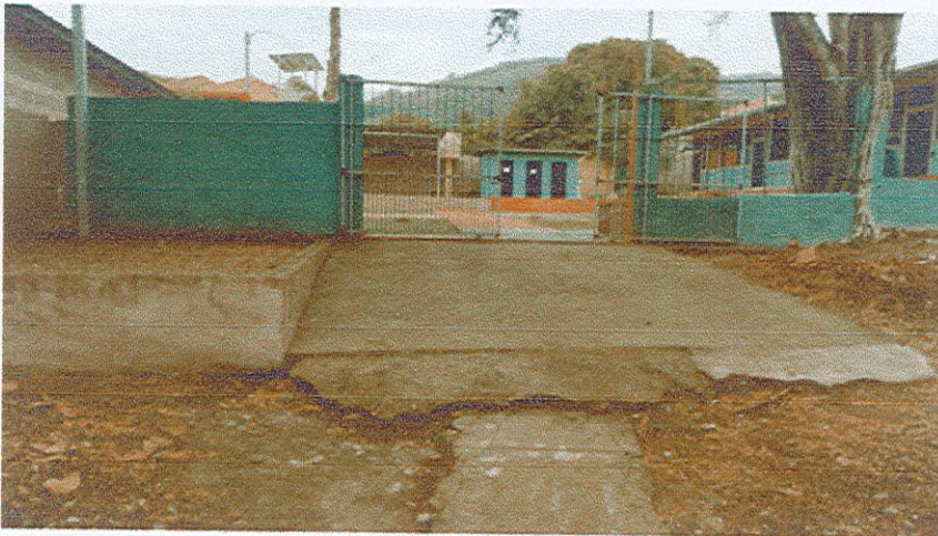
REPARACION DEL CERCO PERIMETRAL DEL KINDER DE LA INFOP
