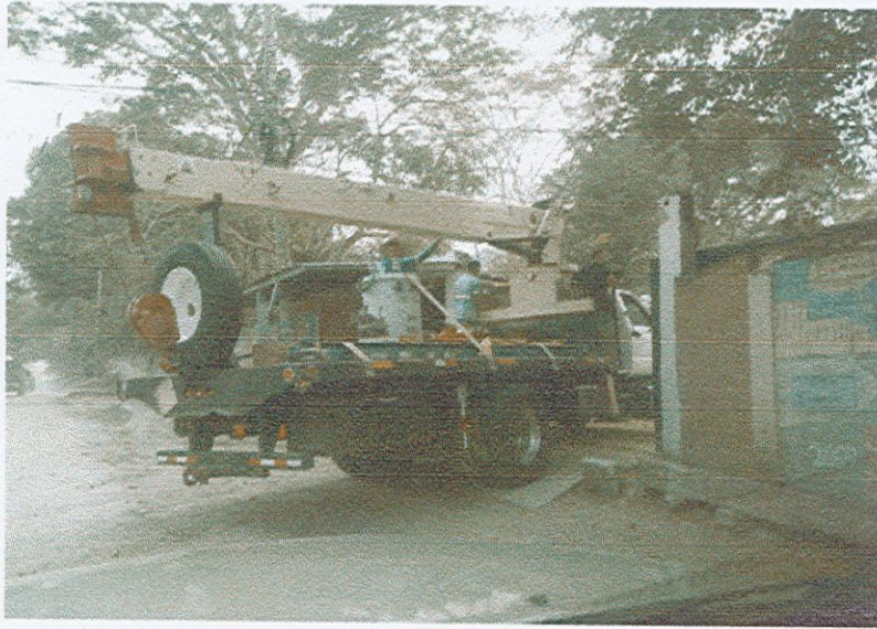
construcción del modulo de baños y construcción de tanque Escuela Clodoveo Omar Tovar de la Col. Morelos.
