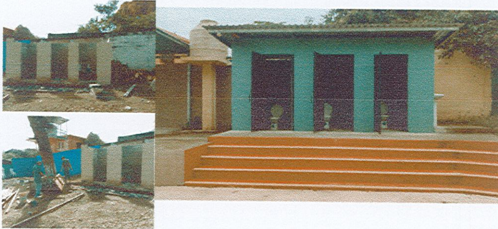
REPARACION DE BAÑOS DEL KINDER DE LA INFOP
