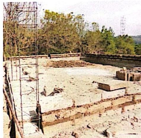
**Descripción:** construcción de arranques fundados de piedra cemento y columnas a base de varillas de 3/8 y lisas, sé utilizo madera para sostener la fundición, se coloco castillos para que quede resistente a base de varilla y como se puede observar ya se empezó a colocar el adobe
