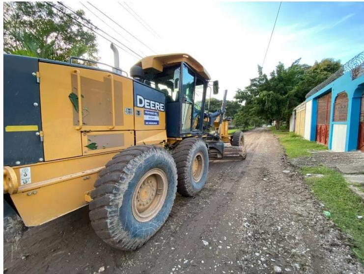
Motoniveladora y vibro compactador en escarificado, conformación, cuneteo y vibrado de calles en colonia Villa Bosques.
