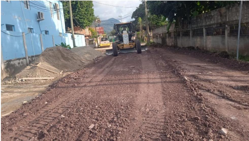
Trabajos de escarificado, conformación, cuneteo y vibrado de calles en colonia Miravalle.
