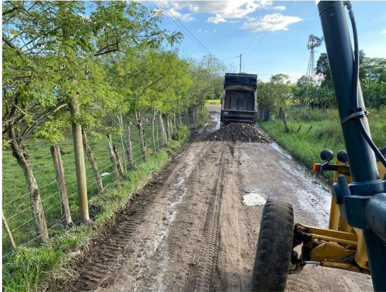
Motoniveladora y vibro compactador en escarificado, conformación, cuneteo y vibrado de calles en colonia Nueva Esperanza.
