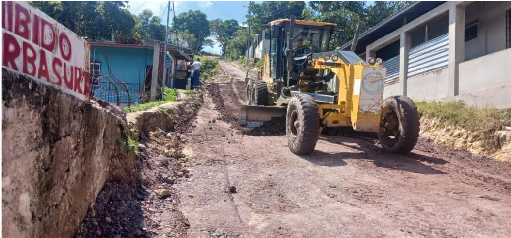
Motoniveladora y vibro compactador en escarificado, conformación, cuneteo y vibrado de calles en barrio Bella Vista.
