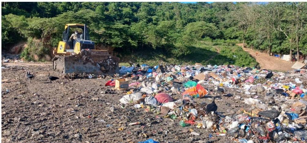
Se aprecia la maquina Bulldozer en trabajos de empuje y soterramiento de basura en el relleno sanitario, barrio El Copante, La Entrada, Nueva Arcadia, Copán.
