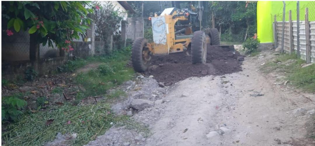
Motoniveladora y vibro compactador en escarificado, conformación, cuneteo y vibrado de calles en barrio Suyapa.
