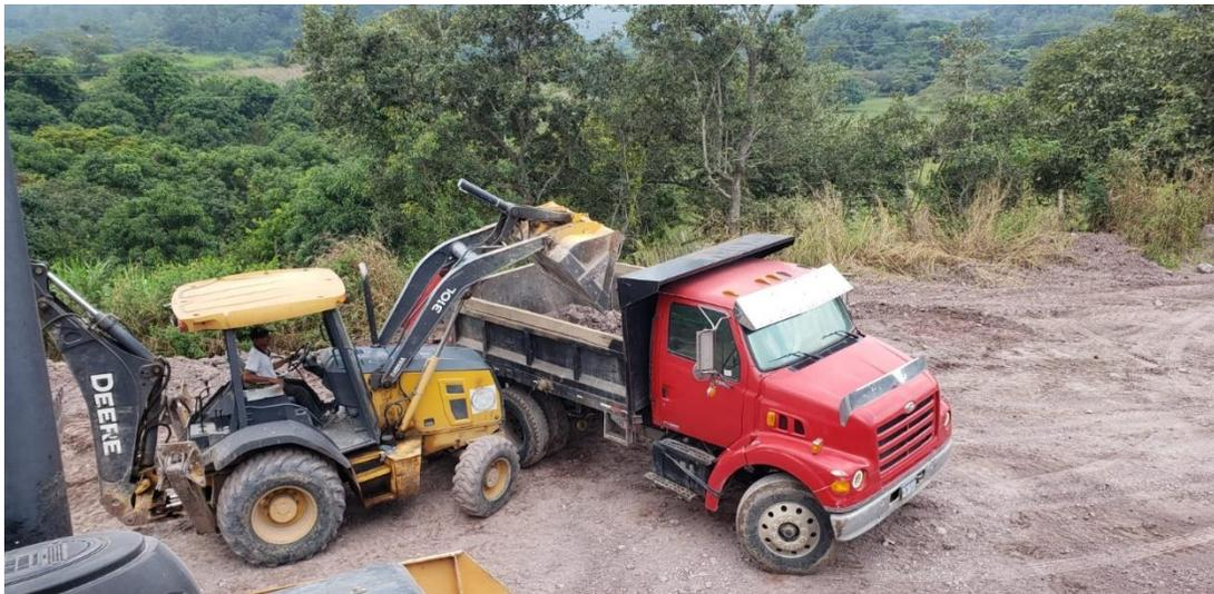
Se aprecia la retro excavadora 310L y al tractor 750J Bulldozer en trabajo de corte y carga de material selecto en aldea Los Pozos.
