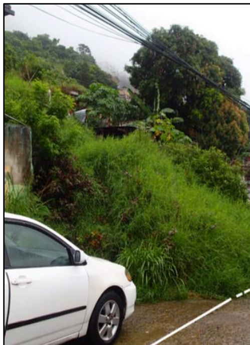
Ilustración 8. Material desplazado a causa del deslizamiento la que bloque una parte de la calle de la parte baja.
