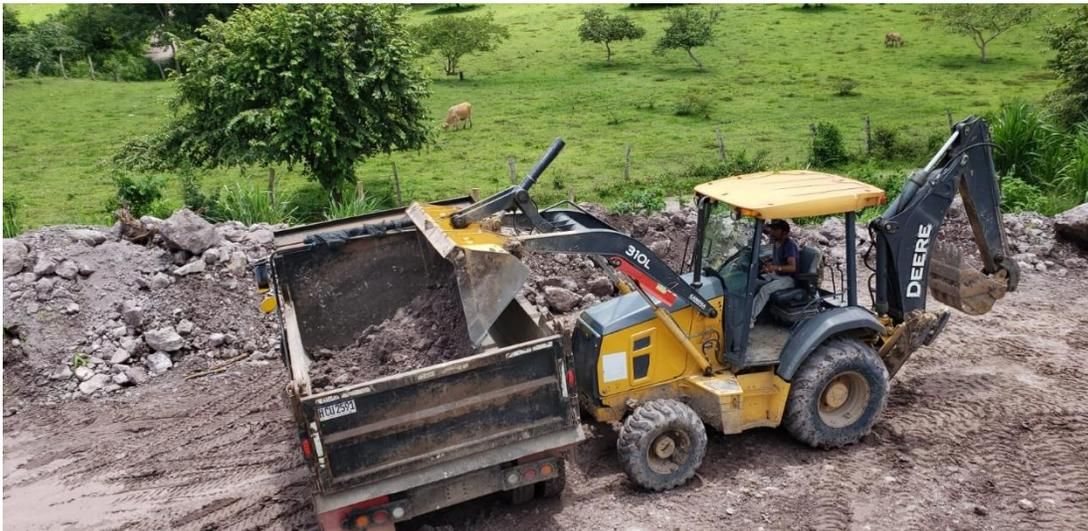
Trabajos de corte y carga de material selecto en aldea Los Pozos para balastado de calles del barrio Las Brisas..
