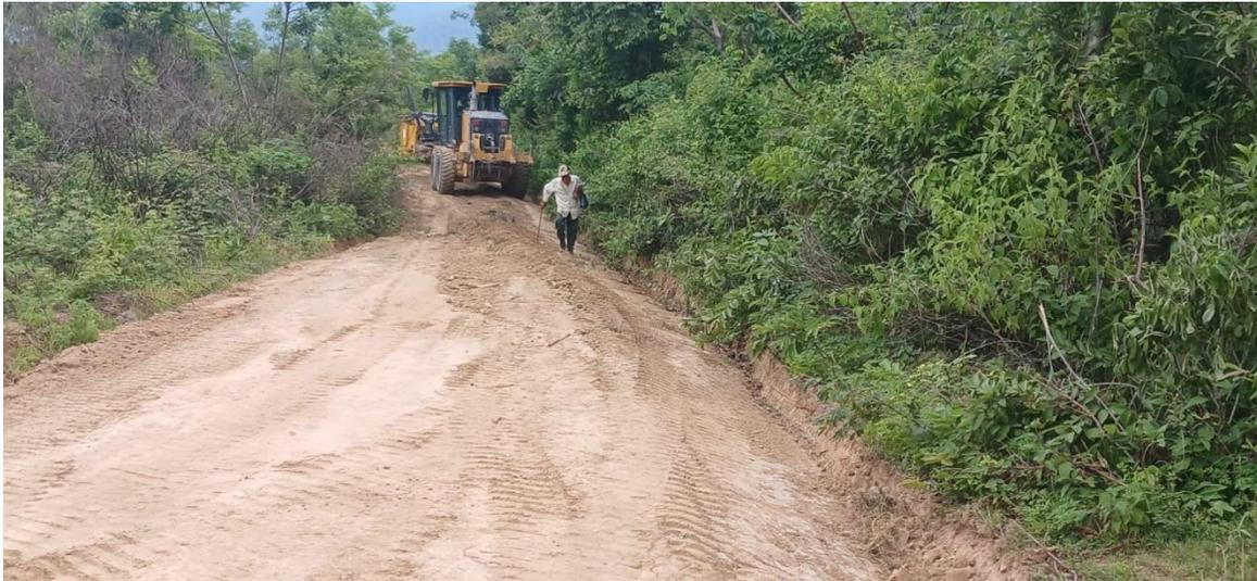
Trabajo de escarificado, conformación, cuneteo y vibrado en calle que conduce de El Llanon hacia el barrio Copante.
