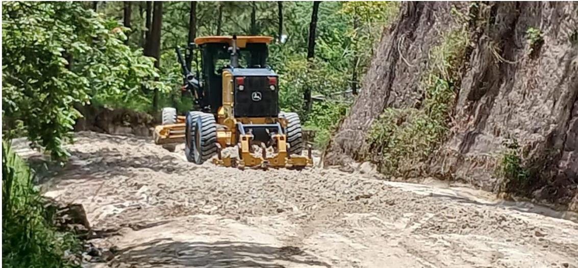
Trabajo de escarificado, conformación, cuneteo y vibrado en calles del Orégano.
