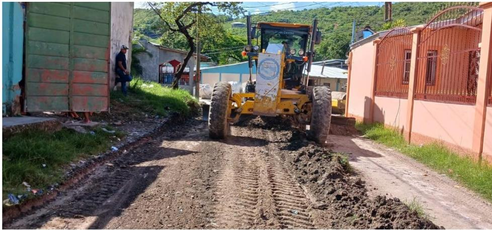
Trabajo de escarificado, conformación, cuneteo y vibrado en calles en barrio Las Brisas.
