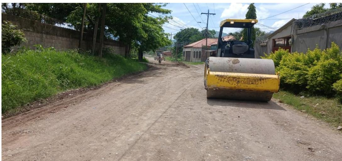
Trabajo de escarificado, conformación, cuneteo y vibrado de calle que conduce de barrio El Dorado hacia aldea Santa Luz.
