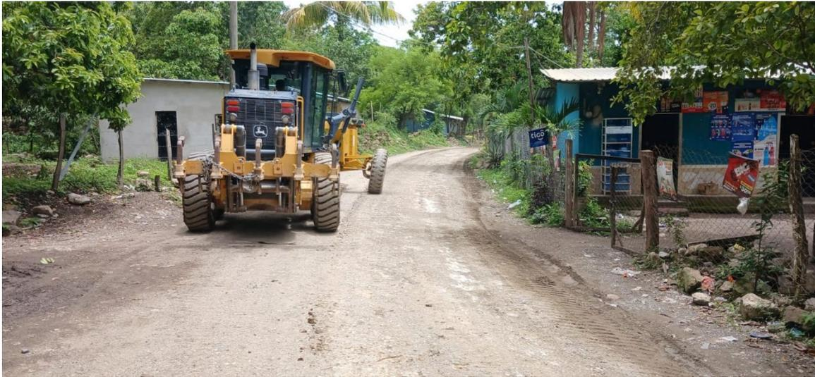
Trabajo de escarificado, conformación, cuneteo y vibrado en calle que conduce de aldea Santa Luz hacia aldea de Quebrada Seca..
