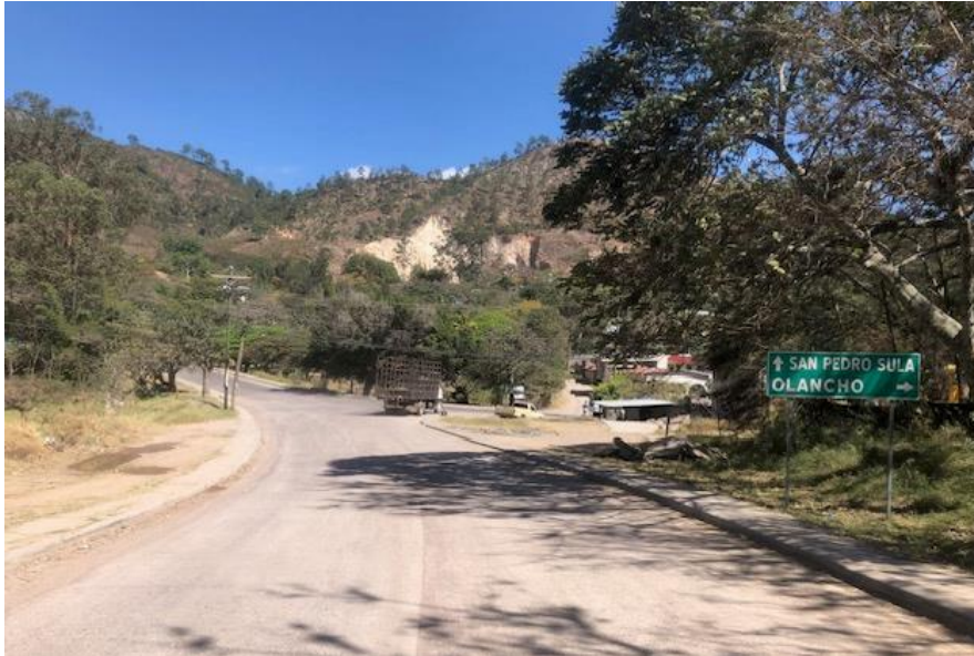
Intersección a intervenir, carretera N-64 (El Durazno – La Laguna) y la calle RN79 hacia salida a Olancho
