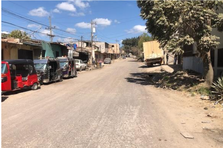
Inicio del proyecto de diseño de pavimentación de la carreta EL Lolo (N-64)
