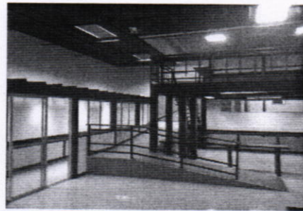
Rampa metalica de acceso a nivel de salas de estudio de grabacion.
