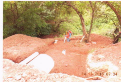
Trabajos de la Construcción del Disipador
