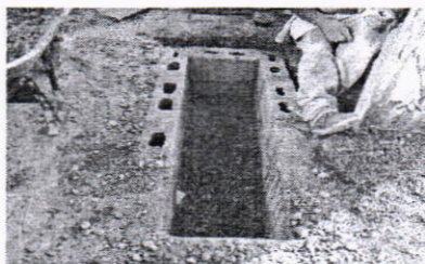
Construcción cajas de registro
