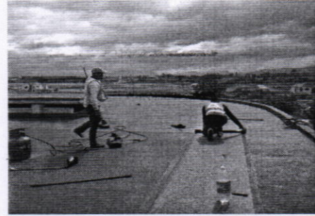
Instalación de las membranas impermeabilizantes
