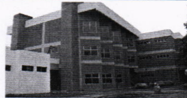
Fachada Norte, módulo B
