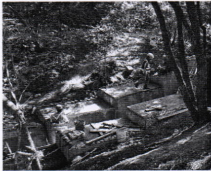
Trabajos en canal de Jardín Botánico.
