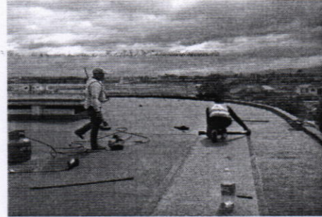
Instalación de las membranas impermeabilizantes
