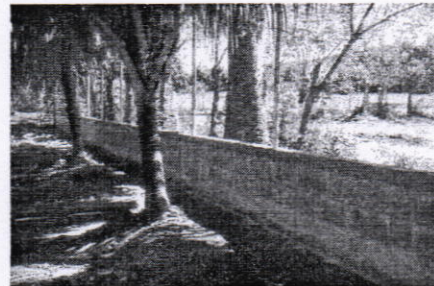
Vista de Cimentacion de Cerco Perimetral Granja Avicola Lado Sur (20-12-2016)
