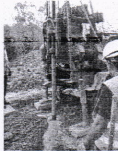
Estudio Geotecnico e Ingenieria de Cimentaciones realizado entre el 3 al 13 de diciembre de 2016
