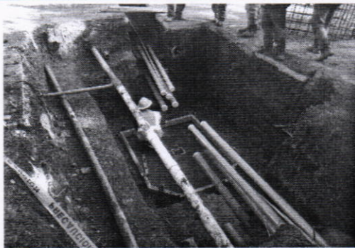
Construcción de caja de registro eléctrica.
