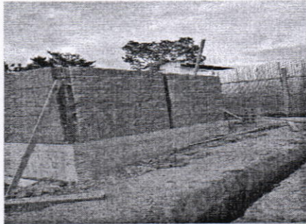
Vista de levantamiento de pared de bloque de concreto (splitface) en el modulo de desinfección personal (19-12-2016)
