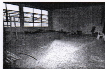
Demolición de piso y firme de concreto
