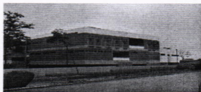
Fachada Oeste Módulo C
