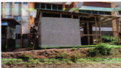
CONSTRUCCION DE OFICINAS Y BODEGAS
