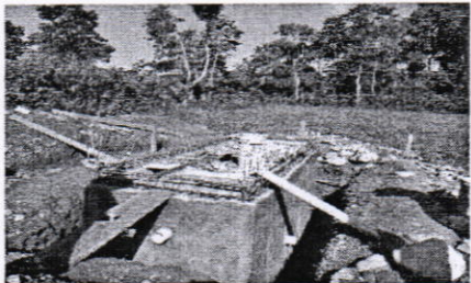
Vista de Construcción de fosa séptica del modulo de desinfección personal (20-12-2016)
