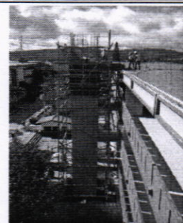
Vista de encofrado para cubo de elevador edificio A2
