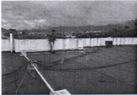
Vista de las tuberías eléctricas sobre los dados de concreto en losa Azotea 1
