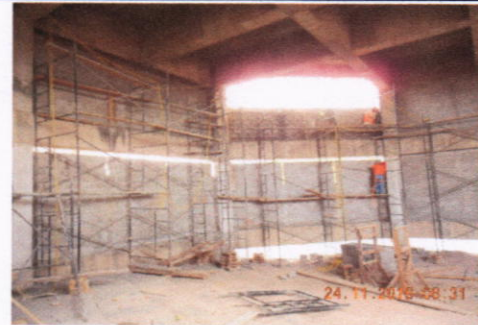
Paredes de bloque en Auditorio
