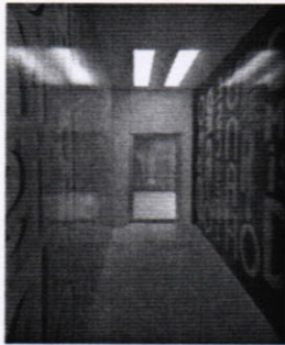
Pasillo de ingreso al Salon
