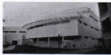
Fachada Sur, Modulo D
