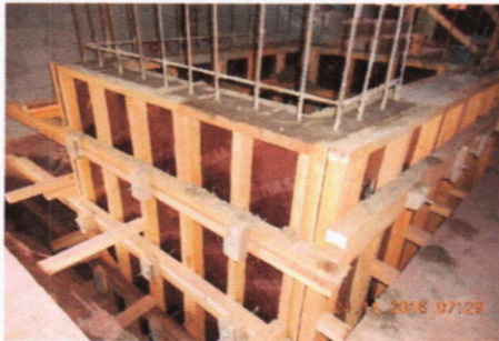
Encofrado para la Fundición del Cubo del Elevador
