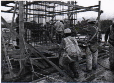
Vista de fundición de cubo de elevador Edificio F1
