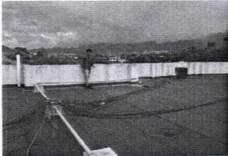
Vista de las tuberías eléctricas sobre los dados de concreto en losa Azotea 1
