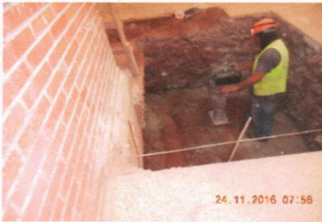
Relleno con Suelo Cemento
