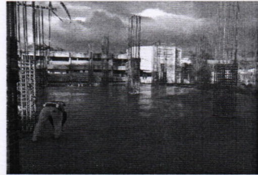
Fundición de losa de Nivel E2.
