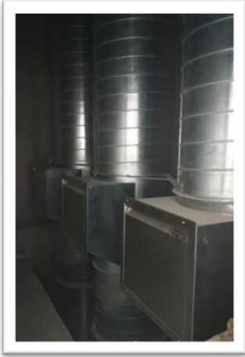
Fig. 1. Ductos de las basuras en el Edificio 1847
