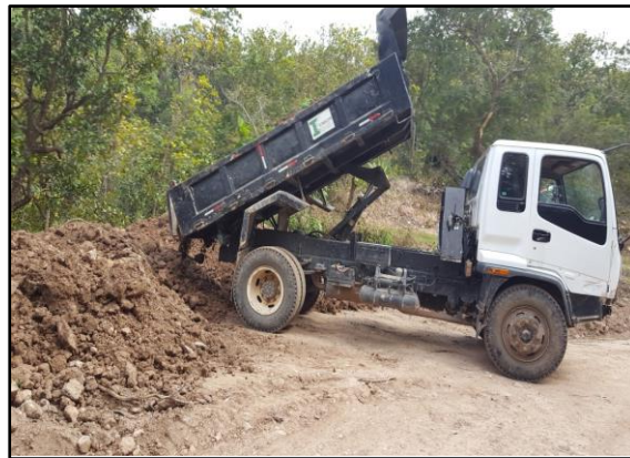
Tramo: El Tizatillo - El Trapiche - Santa Elena Actividad: Botando material sobrante Mecanización Estación: 10+515 a la 10+387 Fecha: 29/12/2016
