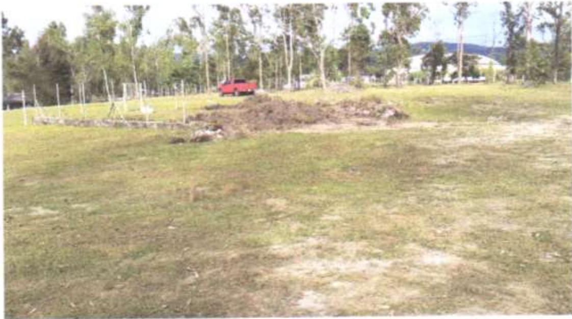
Demolición de Plantel Antigua Estación de Meteorología
