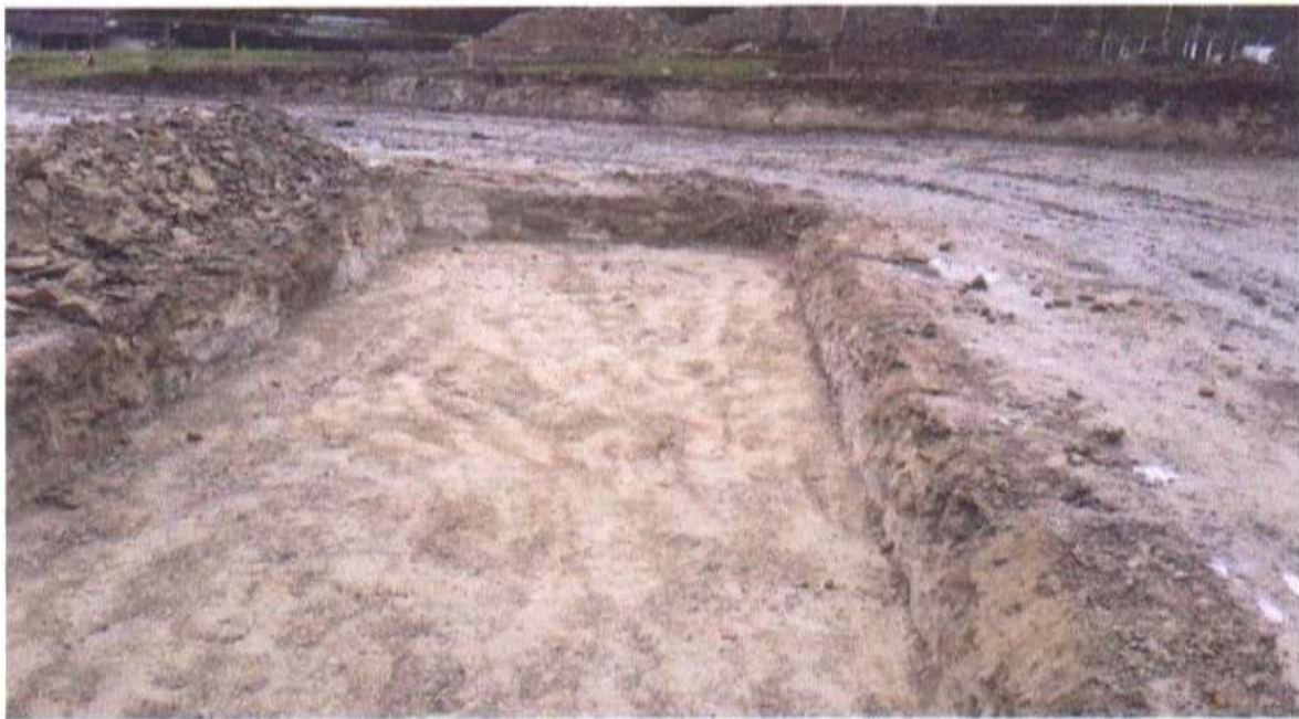
Excavación terreno tipo duro para Zapatas de 3.50 x 10.32 m
