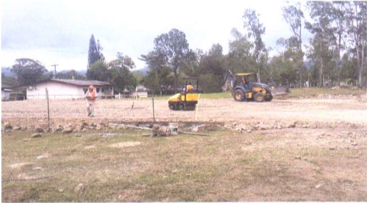
Relleno y compactación del terreno.
