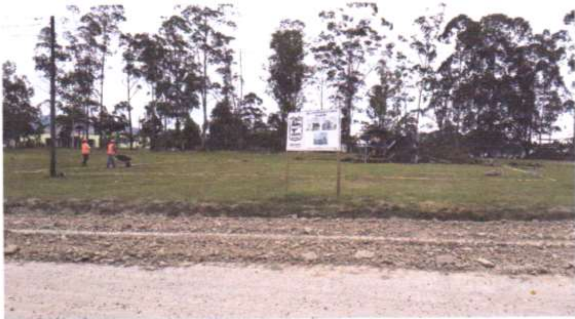
Marcado para Posicionamiento del Edificio
