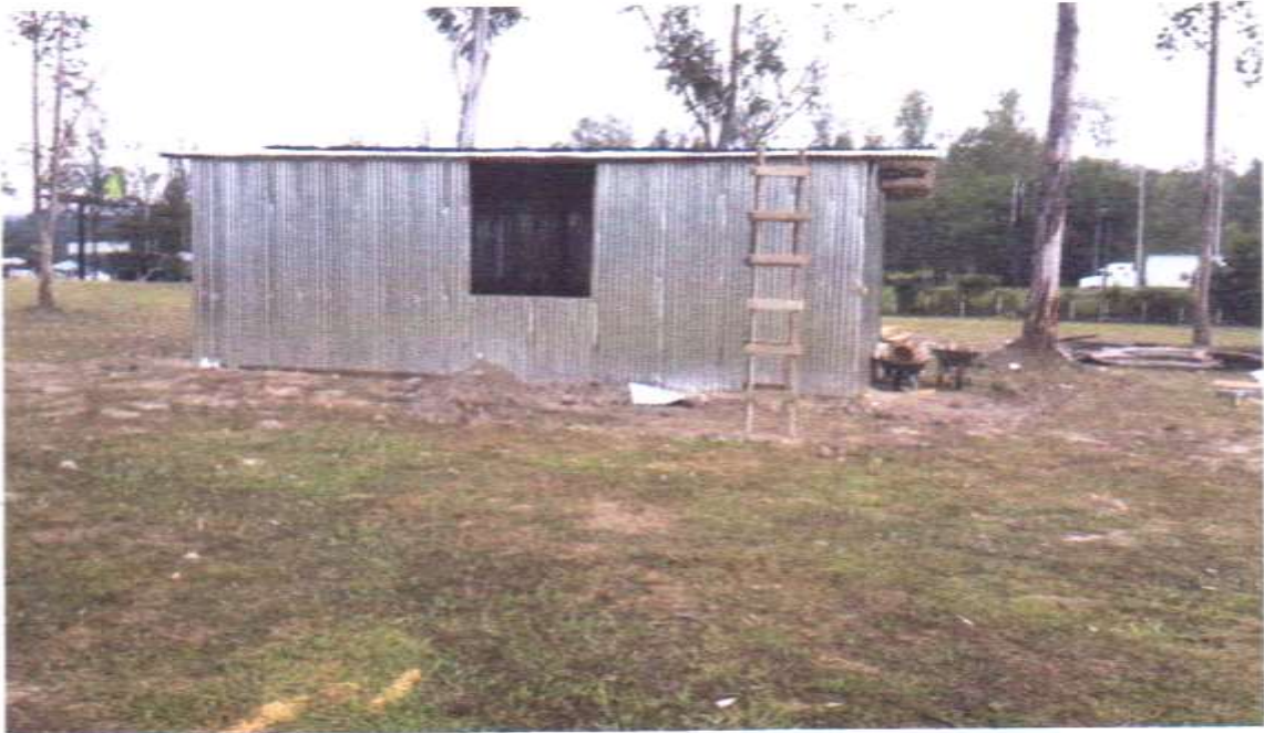
Construcción de Bodega para Materiales
