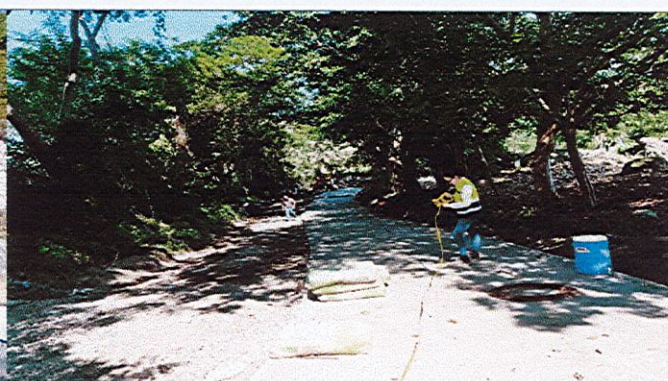
FUNDICION DE CONCRETO
