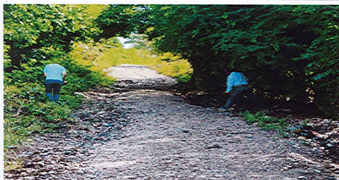
REPLANTEO DE MEDIDAS Y SU TOPOGRAFIA
