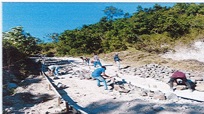
COLOCACION DE NIVELETAS Y EMPEDRADO
