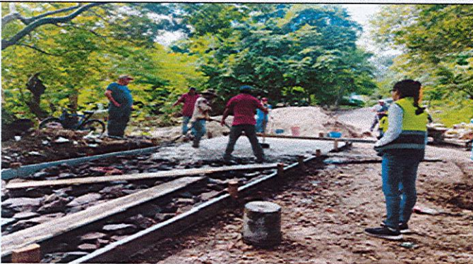
FUNDICION DE CONCRETO
