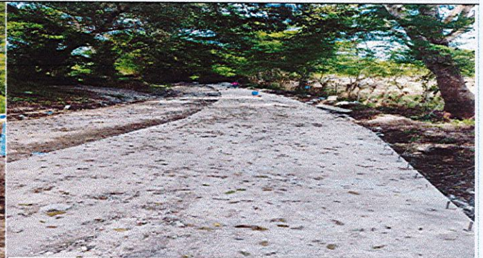
FUNDICION DE CONCRETO
