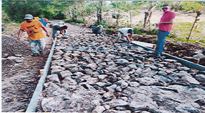
COLOCACION DE NIVELETAS Y EMPEDRADO
