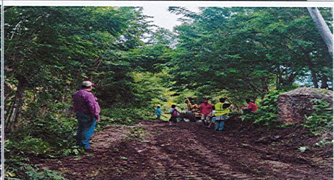
CORTE Y RETIRO DE MATERIAL INERTE
