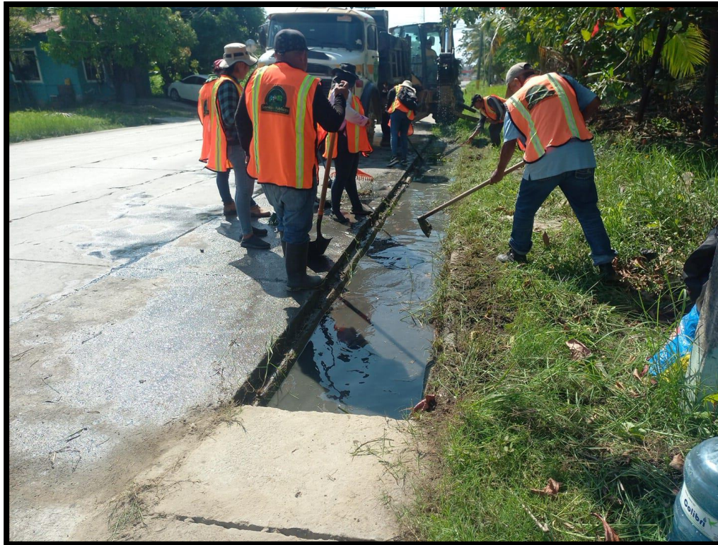
Limpieza de canales pluviales
