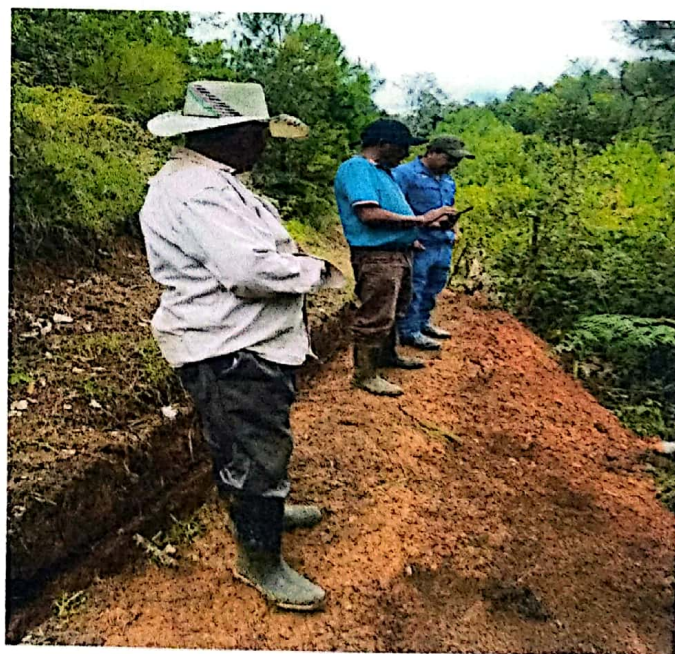
Ilustración 3 visita técnica nuevo tanque sabanetas
