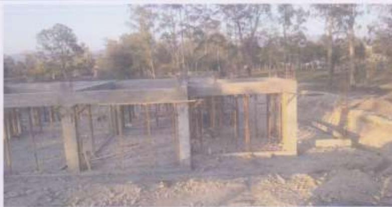
**Fundición de Viga V-2 en losa de Segundo Nivel**
