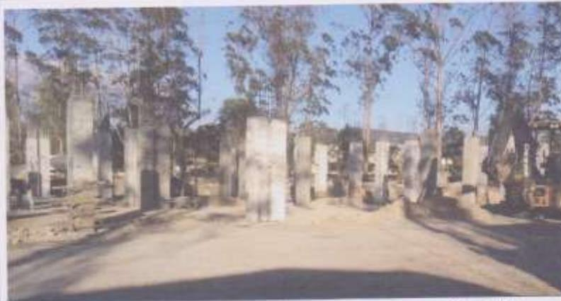
Fundición de Columnas de 45x45cms con varilla 16#4
