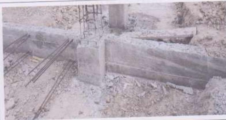
**Se terminó con la fundición de todas las soleras tensoras**
