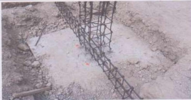
**Se terminó con la fundición de todas las zapatas Aisladas**
