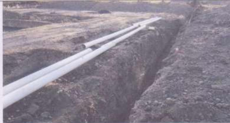
Colocación de tubería para agua potable
