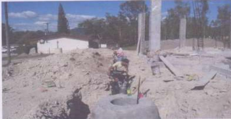
**Construcción de cajas de registro para aguas lluvias**
