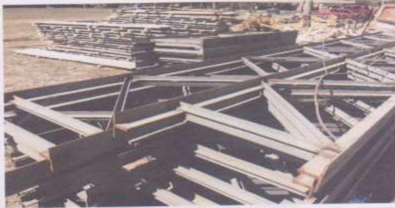
**Armado de Joist con cuerda superior e inferior de ángulo doble de 2"x3/16 y ángulo sencillo intercalado de 1"1/8" a 45°@ 2metros**
