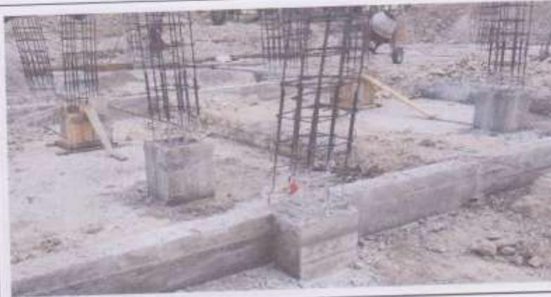
**Se terminó con la fundición de todos los pedestales**
