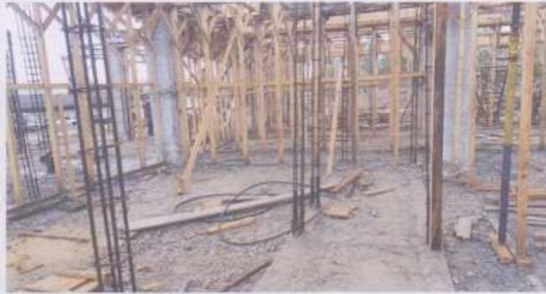
Armado Y colocación de Castillos
