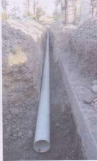
**Colocación de tubería para agua lluvia**
