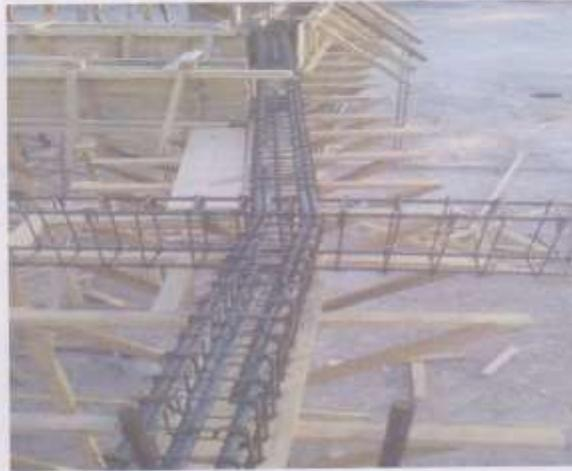
**Armado de Viga V-1 25x46cms Con 4#6,7#5, anillos #3 @0.17
