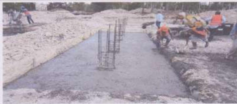
Se terminó con la fundición de todas las zapatas Aisladas
