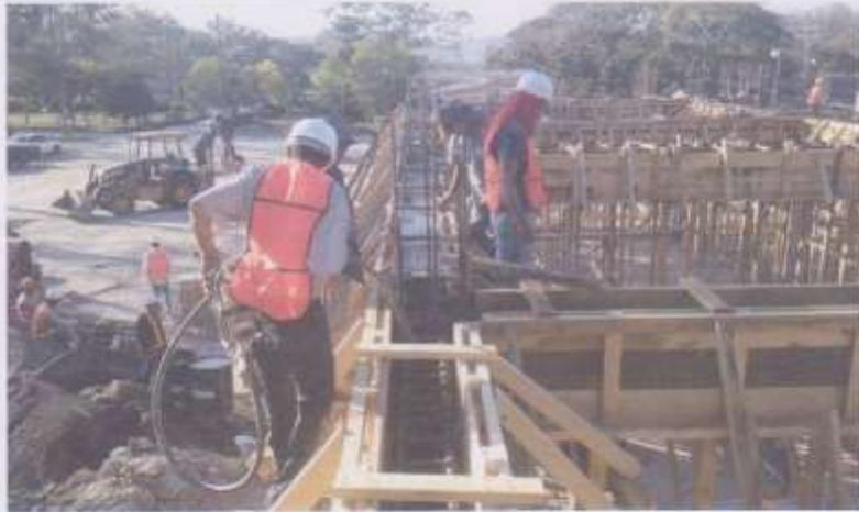
**Armado de Viga V-2 17x34cms Con 4#5,4#4, anillos #3 @0.17
