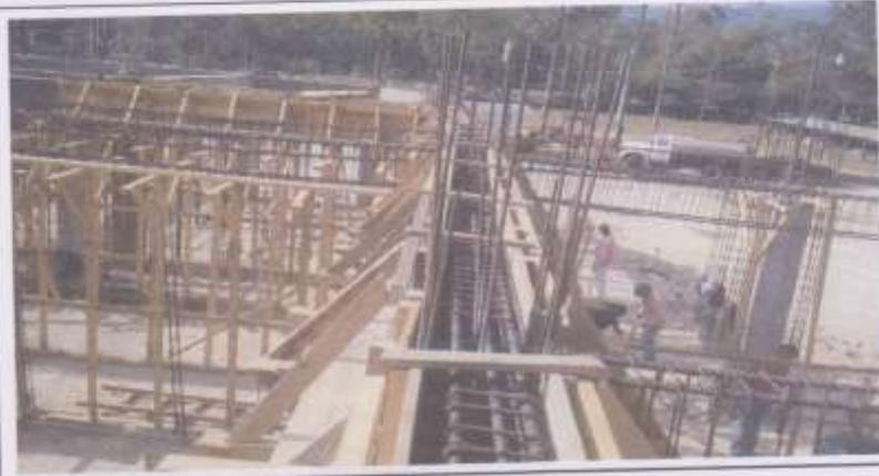
**Armado de Viga V-3 15x30cms Con 8#4, anillos #3 @0.17
