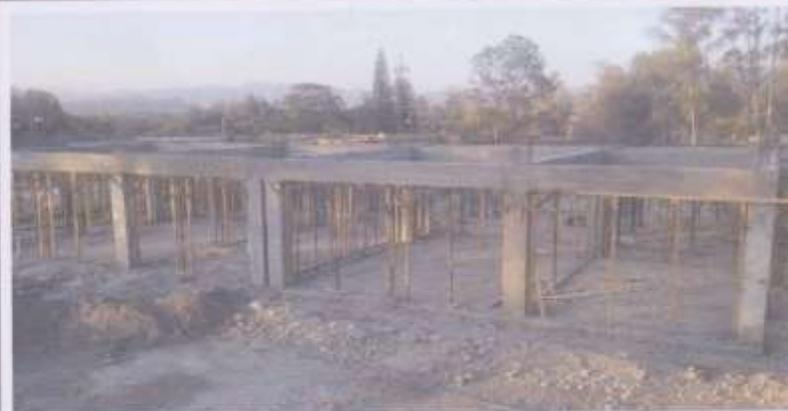
**Fundición de Viga V-1 en losa de Segundo Nivel**
