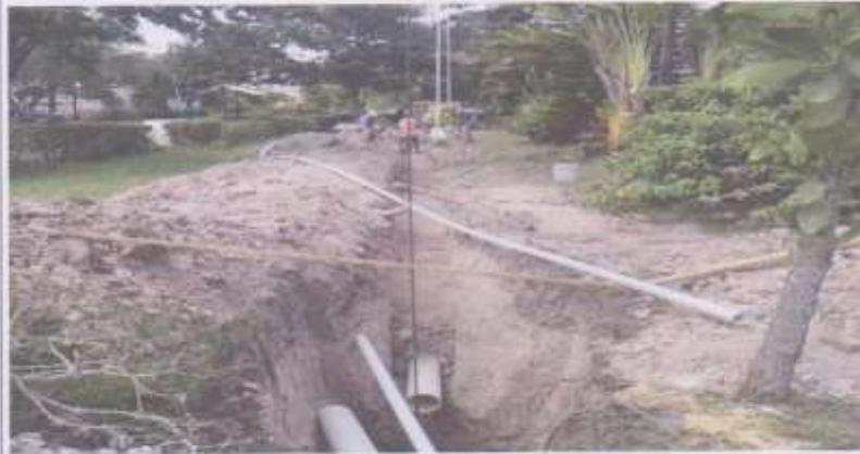
Colocación de tubería para aguas negras
